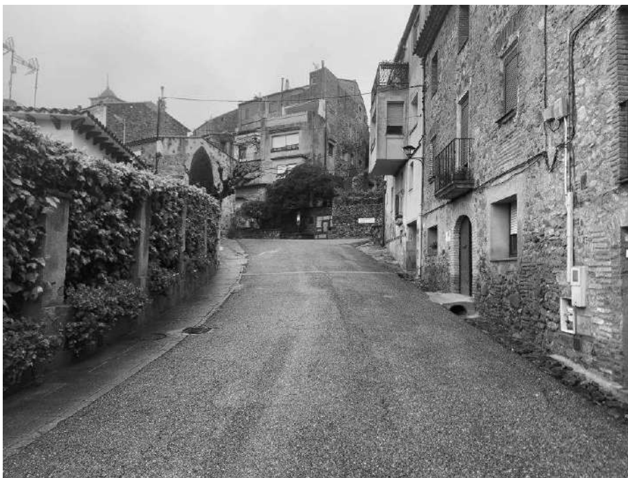
Imatge 04. Vista del carrer Deumera cap al sud, cap a dins del nucli. Actualment, per a accedir a alguns habitatges de la vorera occidental, a a dreta de la imatge, hi ha guals de formigó per salvar el salt entre la calçada i el llinard de l'habitatge. Les obres del present Projecte enrasaran la vorera amb la calçada, amb una cota d'inici just sota les portes dels habitatges, de manera que els guals es demoliran, per deixar de ser necessaris.
