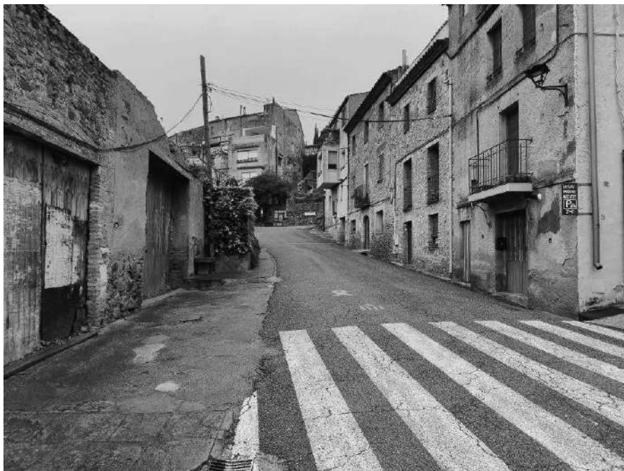
Imatge 03. Vista del carrer Deumera, des de davant del casal cap al sud, cap al final de l'àmbit, cap a dins del nucli. Vorera oriental de llosa de formigó, sobre el canal de recollida de pluvials, i calçada de mescla bituminosa, a fressar..
