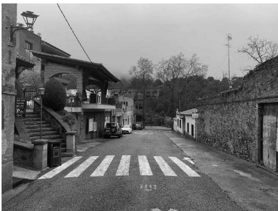
Imatge 02. Vista del carrer Deumera, des de davant del casal cap al nord, cap a l'inici de l'àmbit, als afores del nucli. Vorera oriental de llosa de formigó, sobre el canal de recollida de pluvials, i calçada de mescla bituminosa, a fressar.
