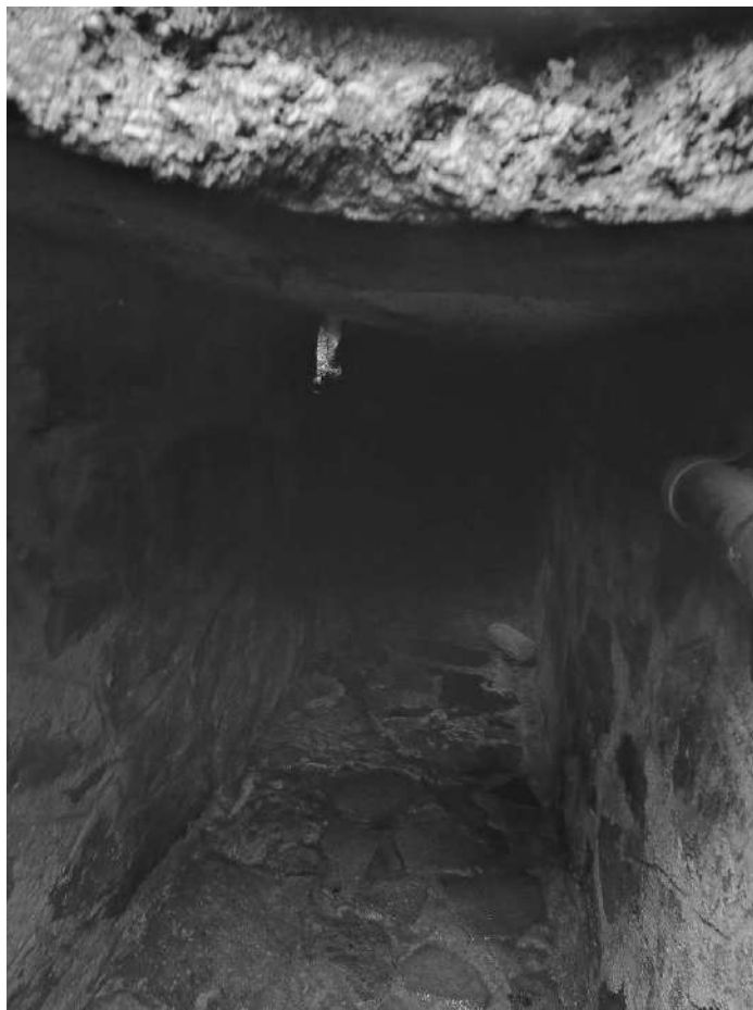
Imatge 07. Identificació de serveis Interior del canal de pluvials.
