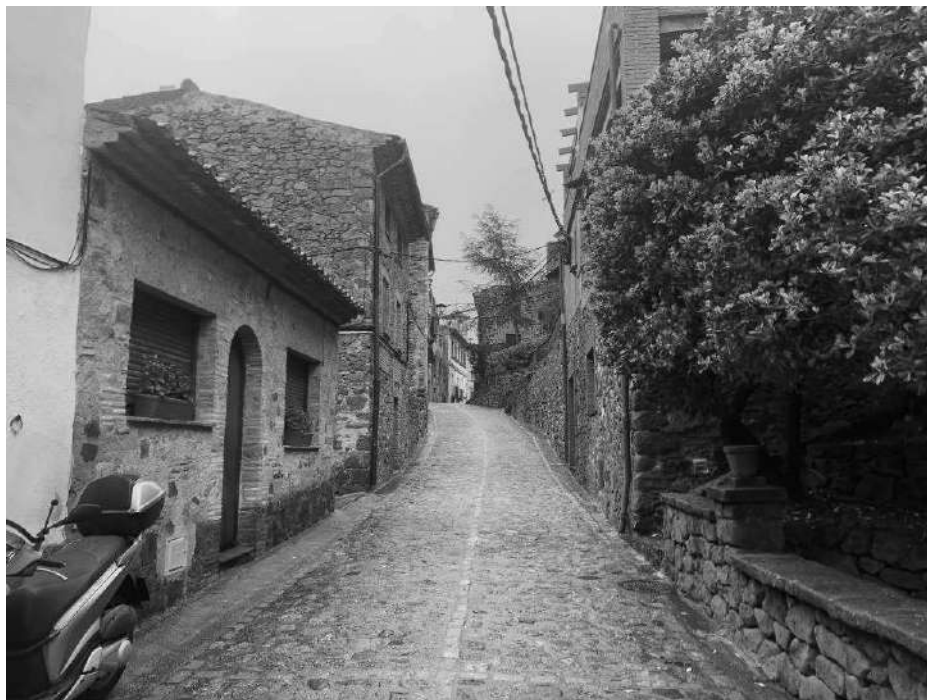
Imatge 05. Pavimentació de la continuació del carrer Deumera cap a l'interior del nucli, feta de pedra local, que serveix de referència per a la definició de la nova pavimentació.
