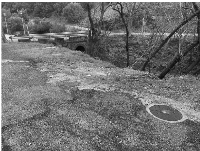
Imatge 01. Inici de l'àmbit. Pont sobre el barranc. Tram inicial del carrer Deumera. PRE 6, identificat al Document núm. 2 Plànols.
