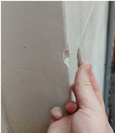
2. Mostreig als emmarcaments de la façana a carrer.
