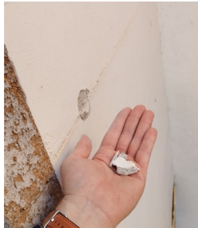
3. Mostra extreta al revestiment de la façana posterior.
