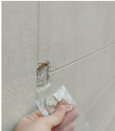
1. Cata al parament general de la façana a carrer de la finca
