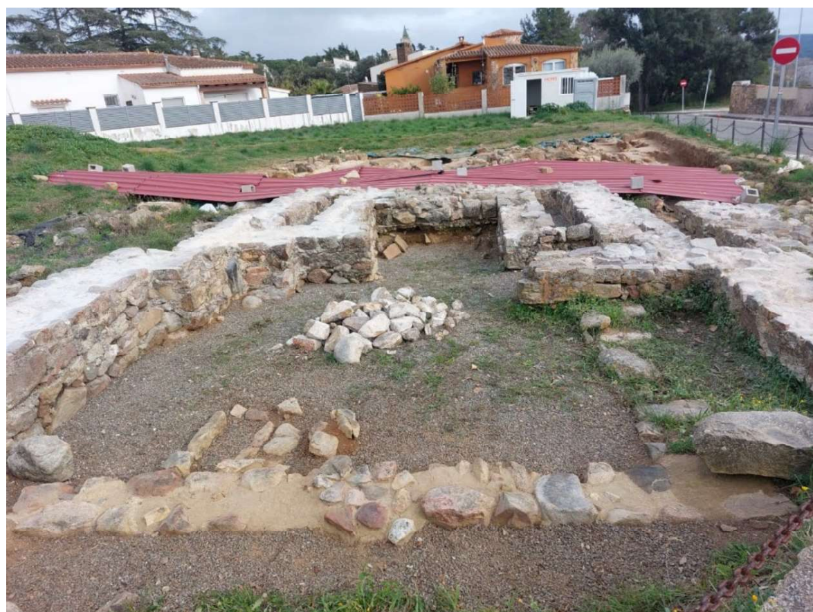
Treballs de restauració dels murs de l'antiga església. Eliminació del coronament pla format amb morter i de la línia de pedres centrals formant una cresta.
