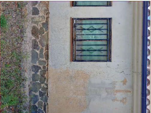
Esquerda vertical en la paret de fàbrica de maó de 5 cm de gruix que hi ha a sota de la bigueta. L'esquerda es pot veure per les dues cares de la paret.
