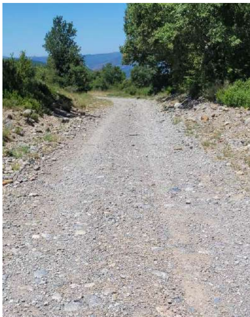
Foto 3: Paviment de terra existent
