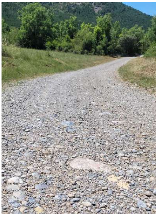
Foto 2: Paviment de terra existent
