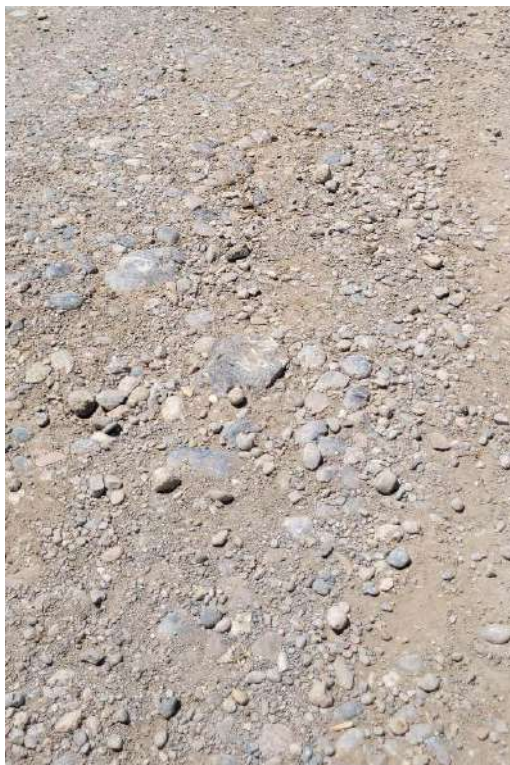
Foto 4: Paviment de terra existent
