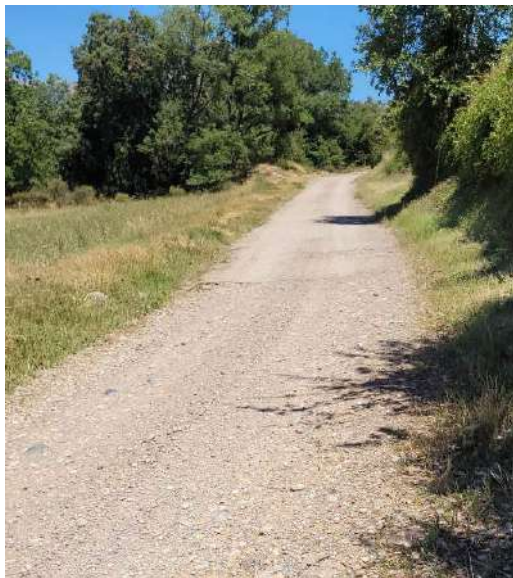
Foto 1: Inici tram a pavimentar
