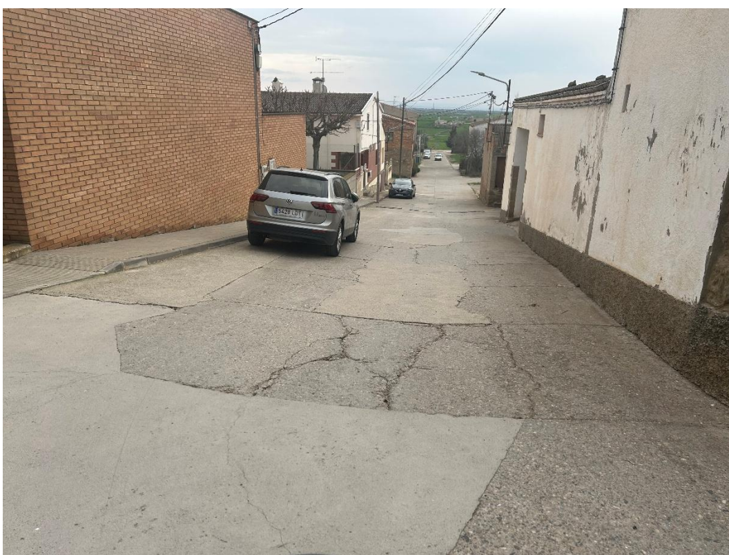
Vista general estat actual Carrer Carretera
