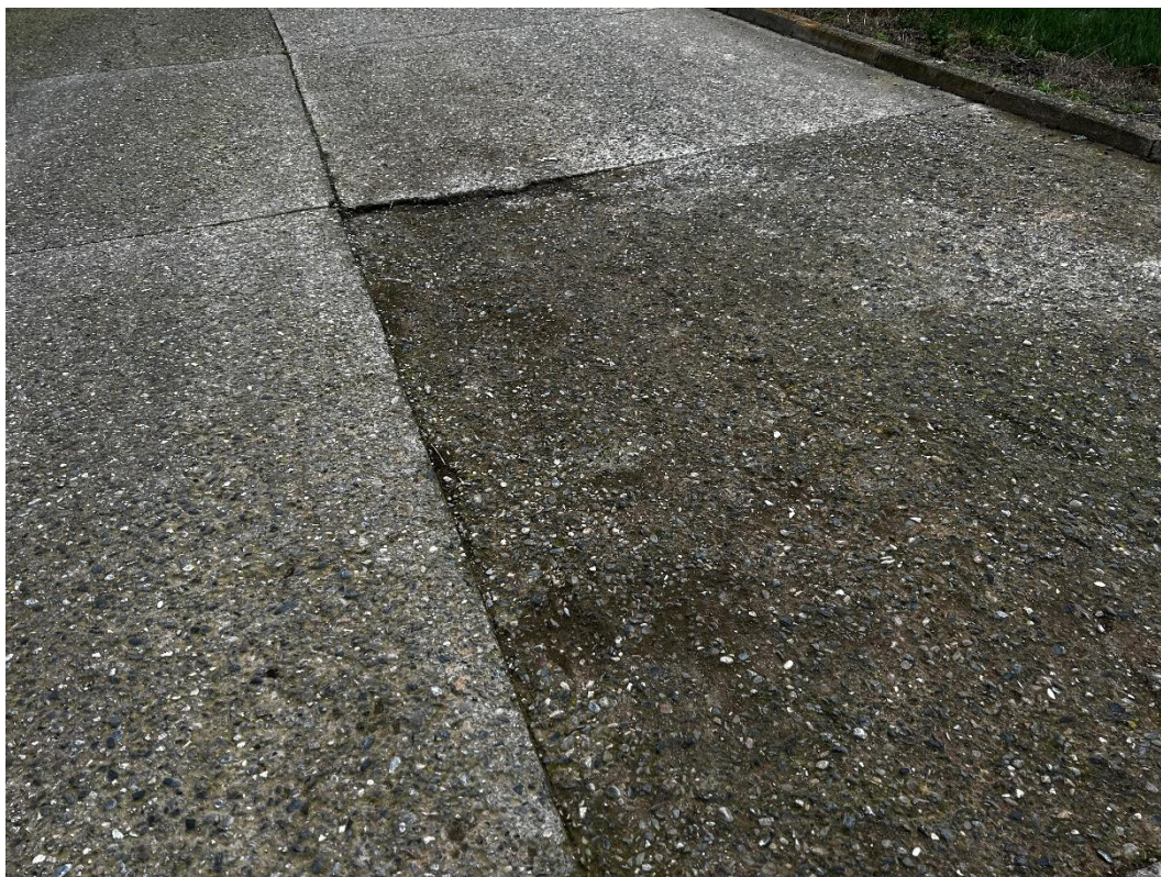
Vista general estat actual Carrer Carretera
