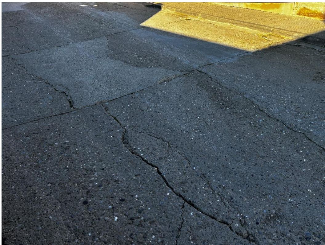
Vista general estat actual Carrer Carretera
