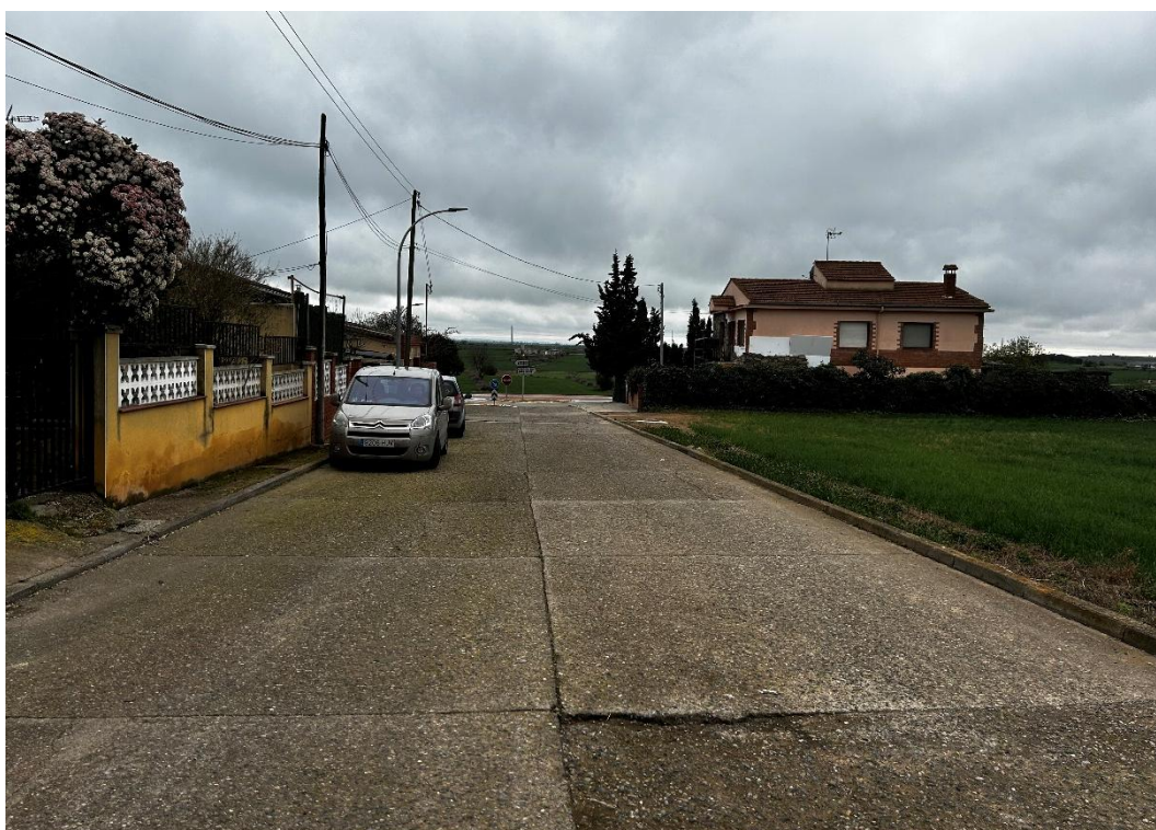
Vista general estat actual Carrer Carretera
