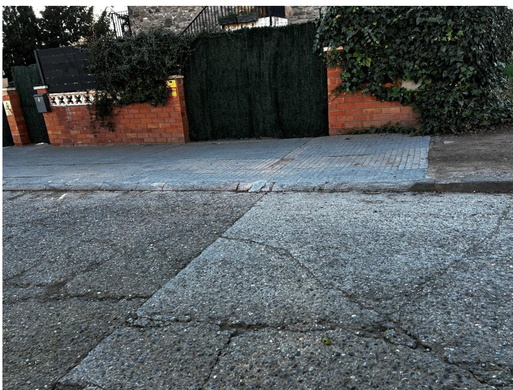
Vista general estat actual Carrer Carretera
