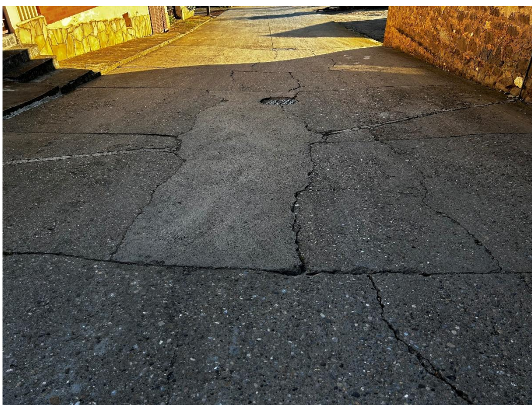
Vista general estat actual Carrer Carretera
