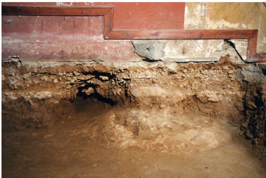
Imatge del recolzament del llenç sud de l'absis, amb la secció dels estrats que suporten la fàbrica gòtica.
