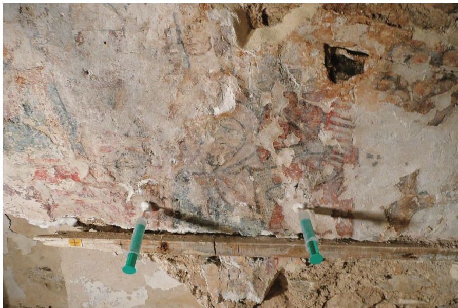
Consolidació de les pintures al suport amb injecció de morter fluid de calç
