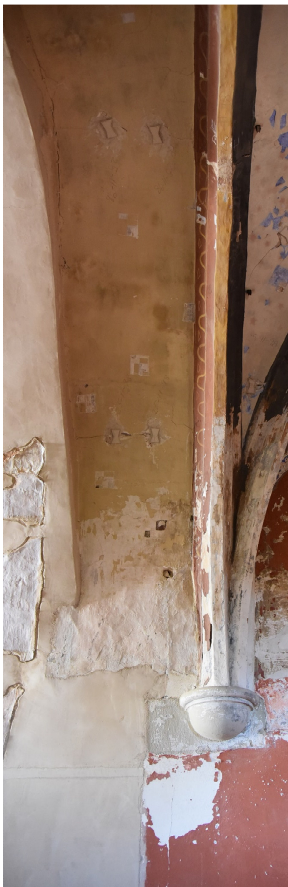
Meitat septentrional de la volta d'enllaç i de l'arcada
