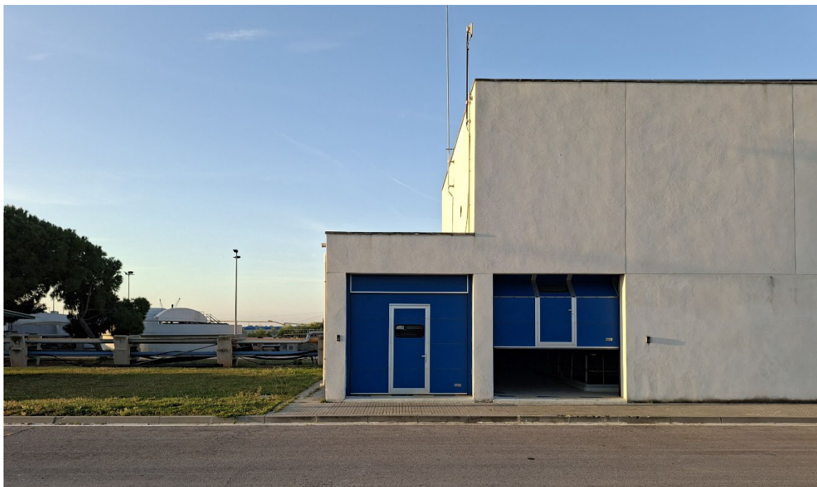
Il·lustració 2 Estat actual vist des de la façana Nord.
