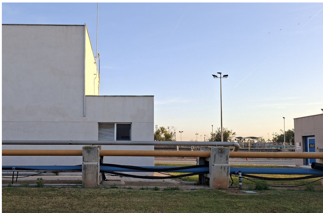
Il·lustració 4 Estat actual vist des de la façana Sud.
