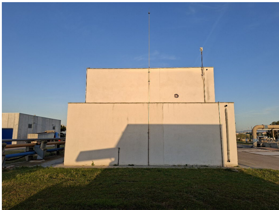
Il·lustració 3 Estat actual vist des de la façana Est.
