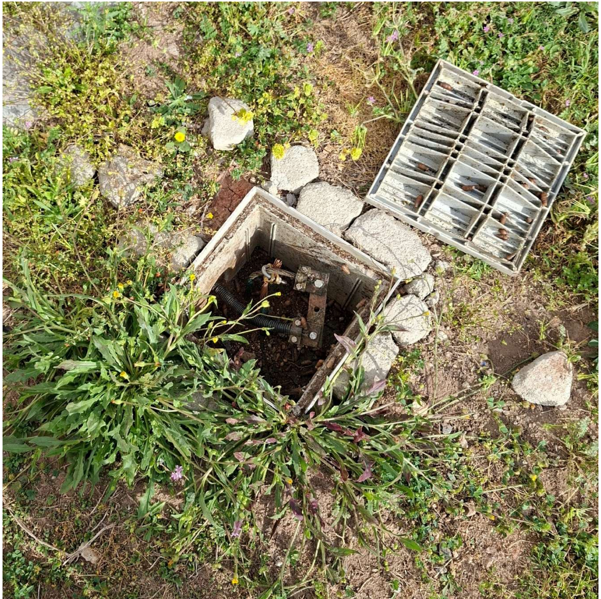
Il·lustració 3 Tapa amb connexió de terra que haurem de mantenir
