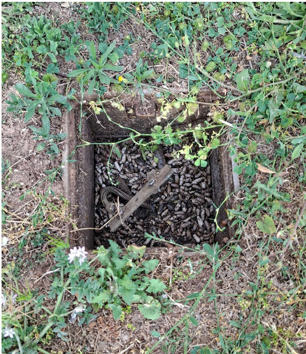
Il·lustració 4 Tapa amb connexió de terra que haurem de mantenir
