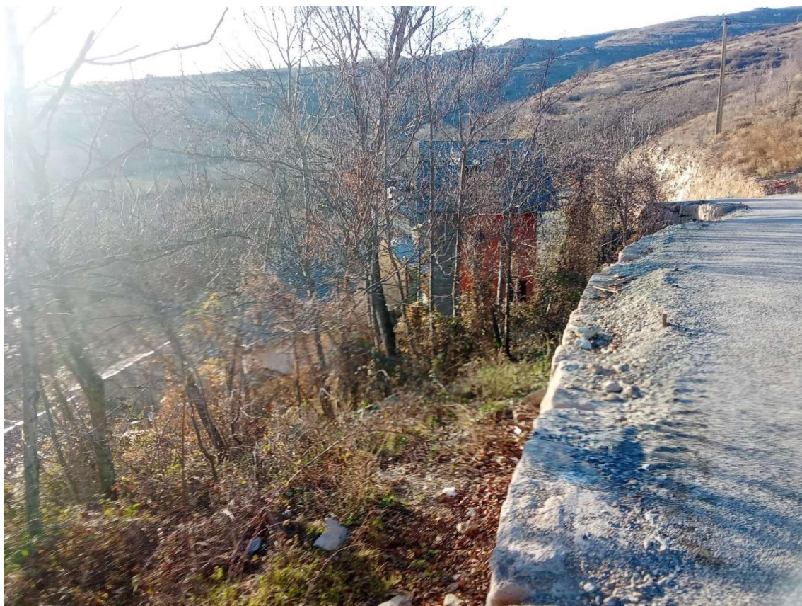
Foto 11. Mateixa fase 2. On s'observa accés rodat fet fa poc que permet arribar àgilment a tota maquinària fins on hi ha la tramada de canals de llauna motiu pel que s'ha utilitzat preus de pressupost diferents als de la primera fase.
