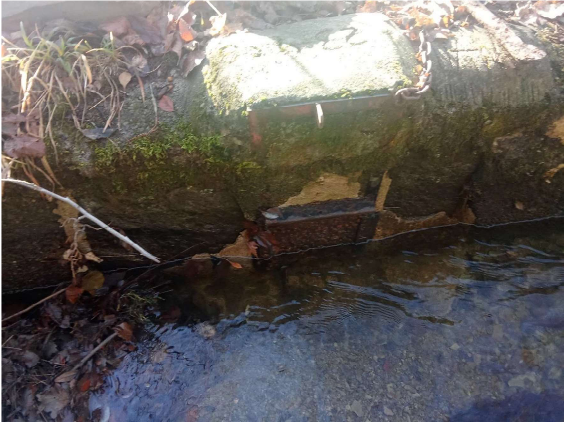
Foto 5.- Detall d'una comporta de derivació amb el seu marc que són les denominades "boqueres" controlades pel regater a la hora de donar torns d'aigua.
