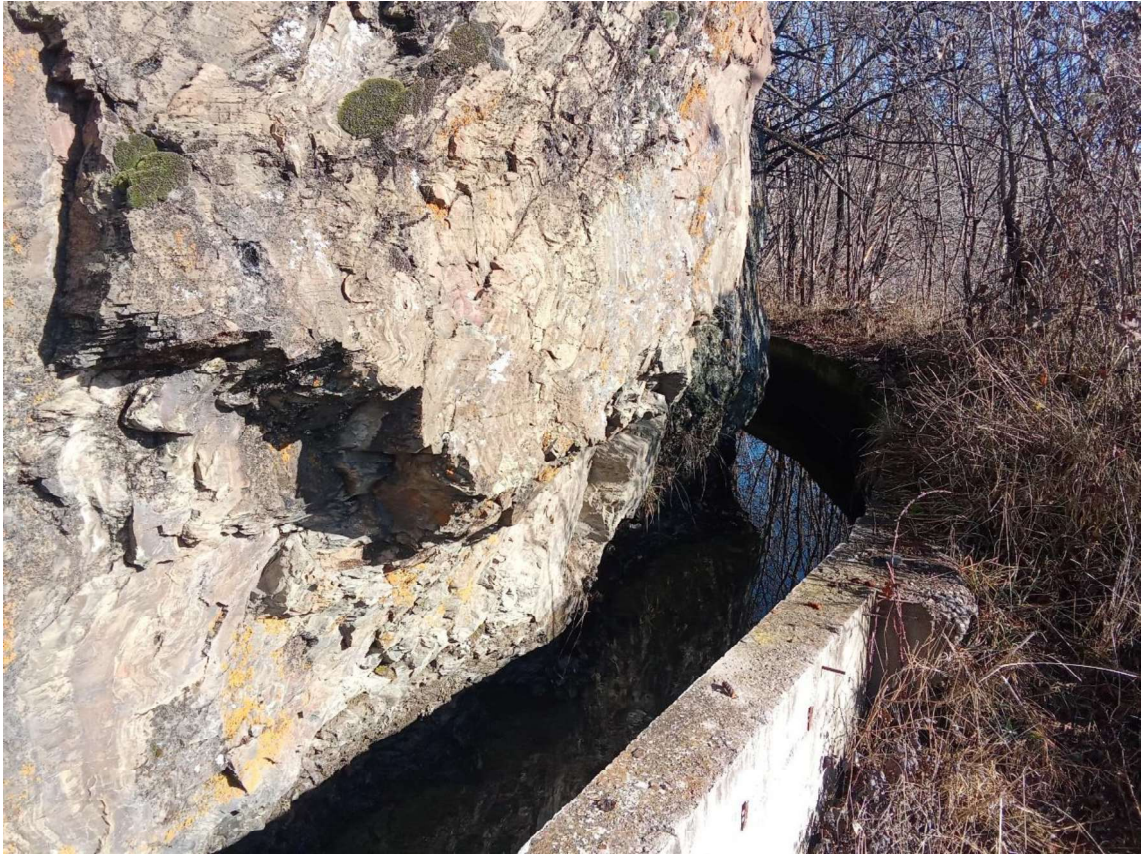
Foto 7.- Tram en el que es va substituir la barana esquerra, però que es projecta de acabar de completar el caixó pel que es necessita tocar la roca amb compresor per buidar-la permetent de fer l'altra barana.
