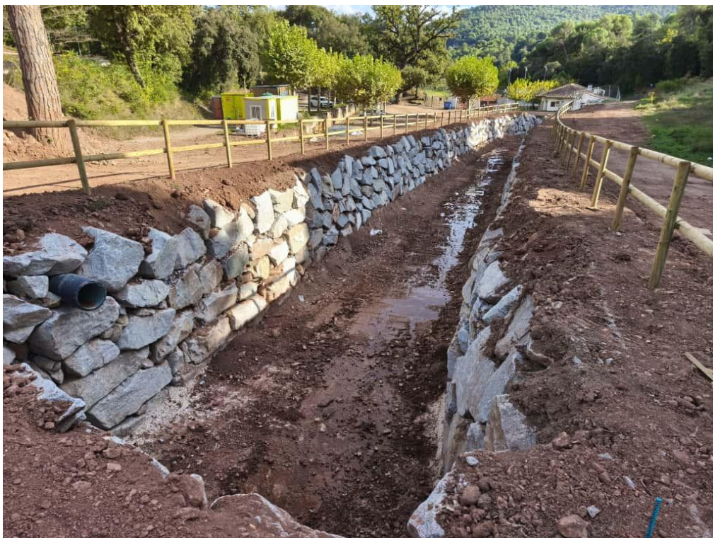
Imatge 1. Vista del tram executat, des del PK0+000, just després del creuament del carrer.
