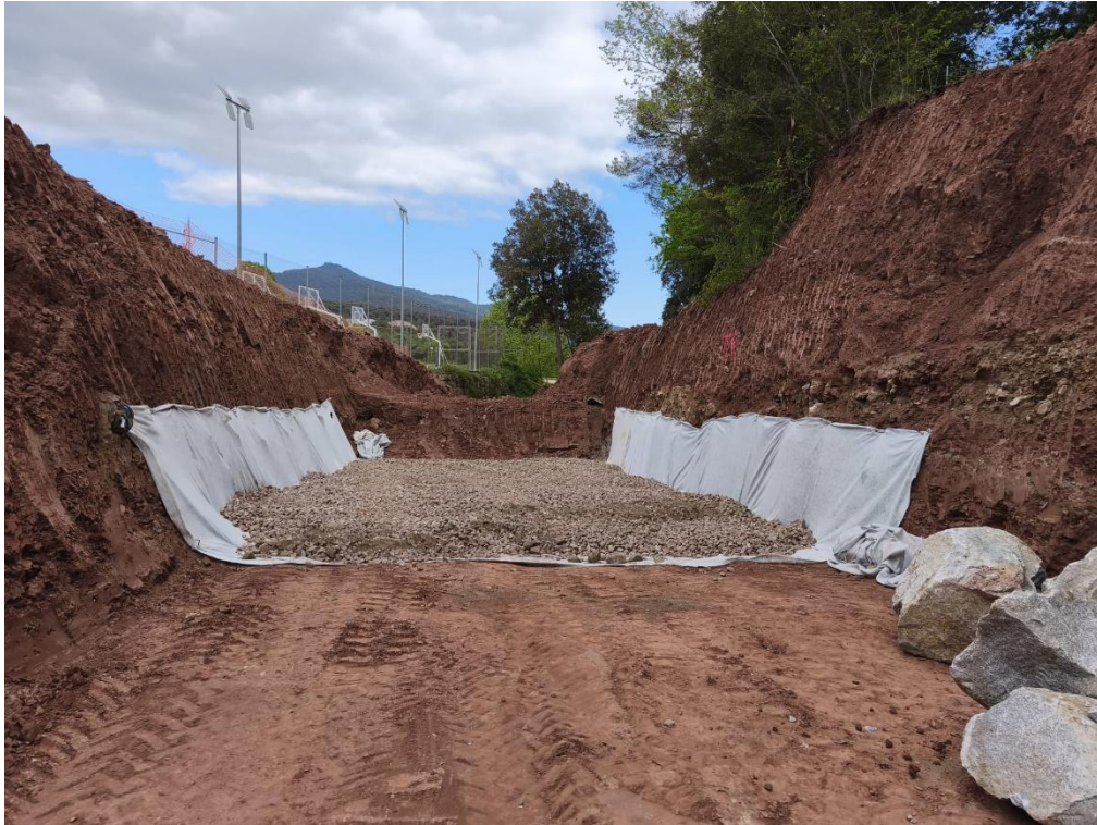
Imatge 6. Vista de la formació de la base del torrent (geotèxtil i grava) en el PK+0+140.
