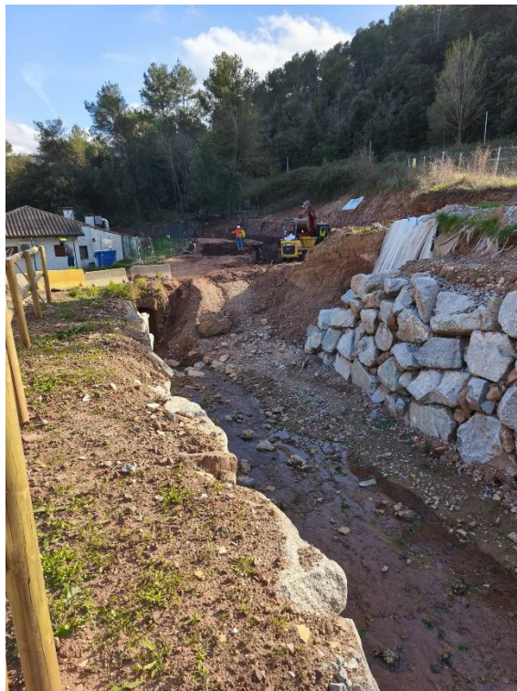
Imatge 3. Vista del punt on s'acaba el tram executat, just abans de la canalització que creua per sota el restaurant.
