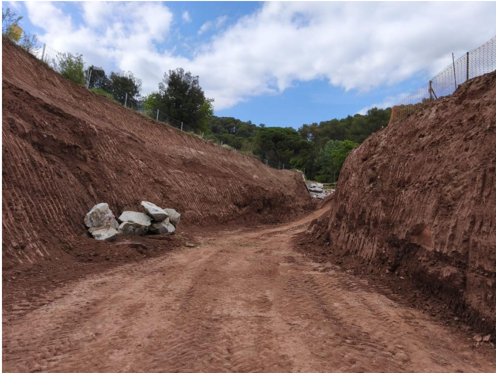
Imatge 4. Vista de l'excavació ja realitzada i apunt per executar la base de l'endegament. La imatge correspon aproximadament al PK0+110 mirant aigües amunt.
