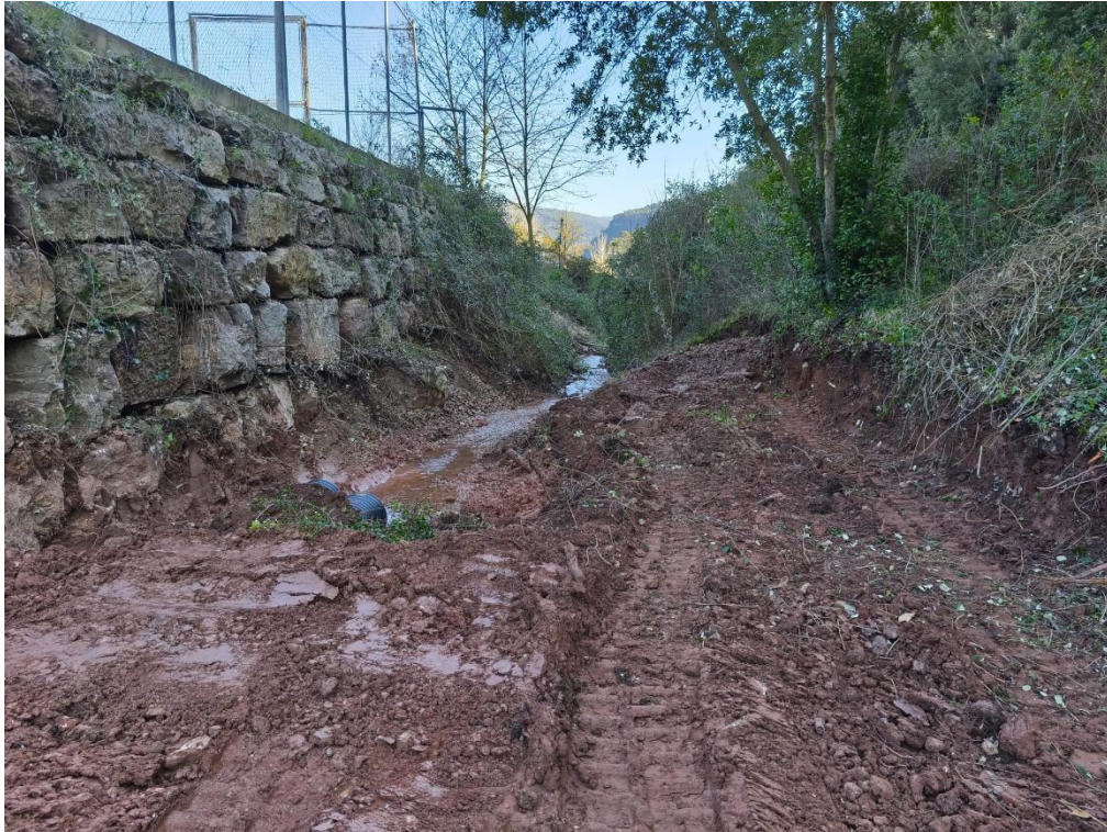
Imatge 8. A l'esquerra s'aprecia la sortida dels dos col·loectors DN500 provisionals, sobre els quals s'ha executat el terraplenat d'aquest costat del torrent.
