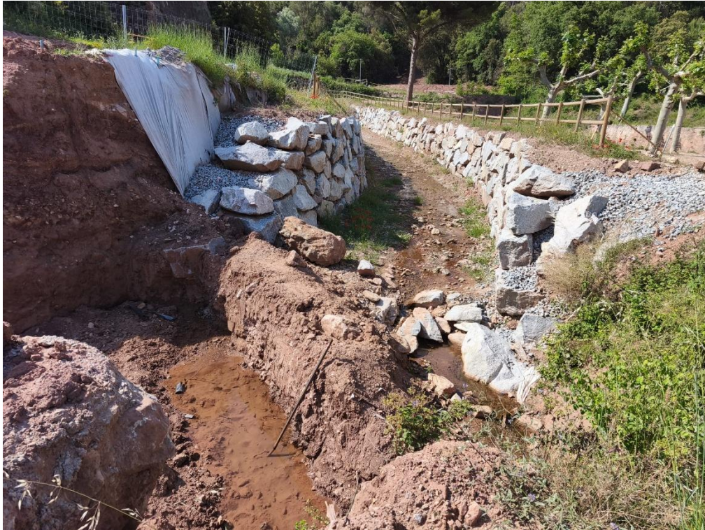
Imatge 2. Vista del punt on s'acaba el tram executat, just abans de la canalització que creua per sota el restaurant. S'aprecia una petita mota de terres per desviar provisionalment l'aigua cap a la canalització sota el restaurant.
