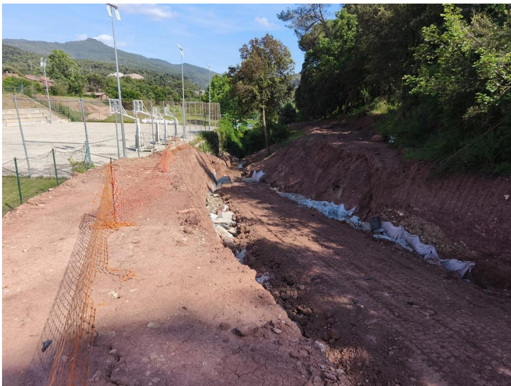
Imatge 7. Vista de la base del torrent executada (geotèxtil, grava, escullera i capa de terra) en el tram entre el PK+0+140 i el PK0+175.
