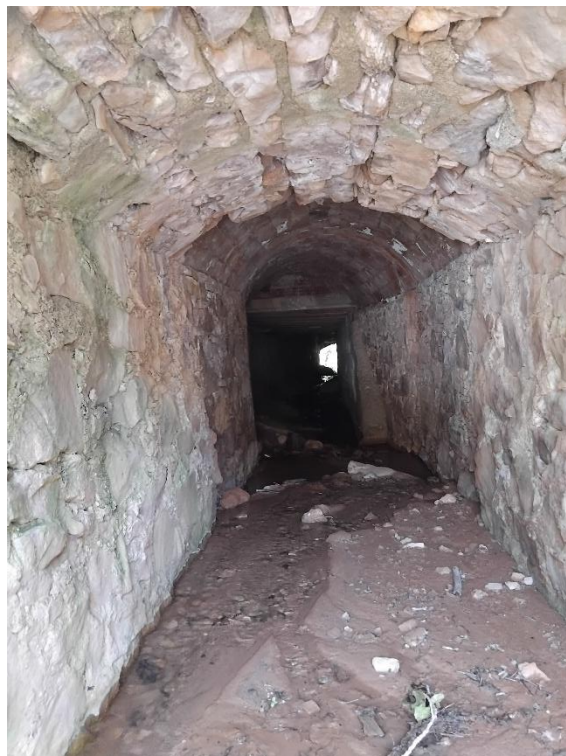
Imatge 9. Tram aigües amunt de la canalització del restaurant que caldrà anul·lar mitjançant el formigonat.
