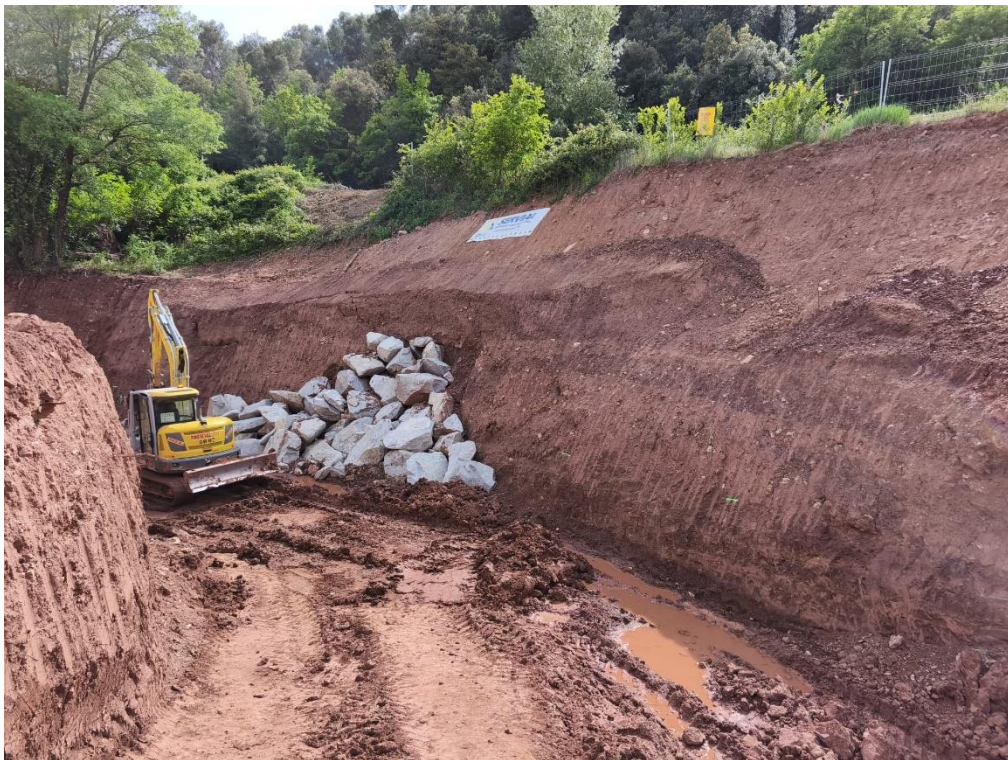
Imatge 5. Vista de l'excavació realitzada pel desviament del torrent pel costat del restaurant. La imatge correspon aproximadament al PK0+080 mirant aigües avall.
