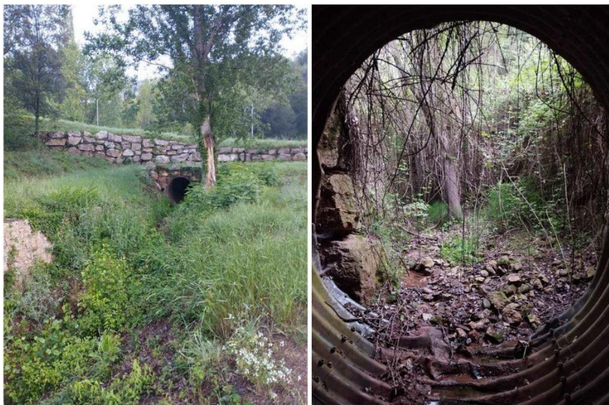
Tub més al nord que passa per sota d'un carrer tallat.
