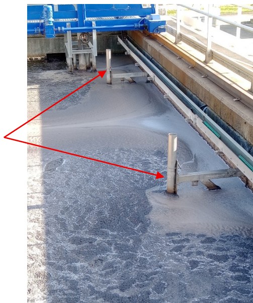
Fotos 9 i 10. Canals amb ubicació dels suports actuals dels aerojets
