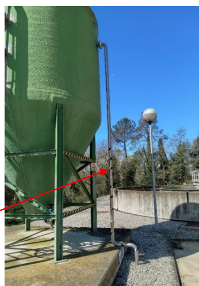
Fotos 16, 17 i 18: Imatges de la canonades de recirculació i de purga cap a la sitja
