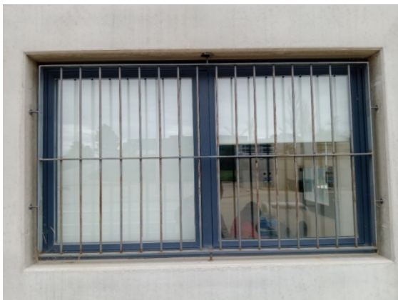
Foto 36: Reixes de l'edifici de l'EDAR de Maçanet de la Selva com exemple
