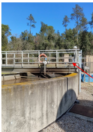
Fotos 16, 17 i 18: Imatges de la canonades de recirculació i de purga cap a la sitja
