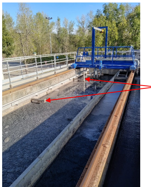
Fotos 9 i 10. Canals amb ubicació dels suports actuals dels aerojets
