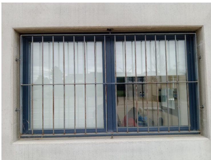
Foto 31: Reixes de l'edifici de l'EDAR de Maçanet de la Selva com exemple
