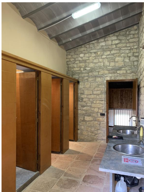
Millora 2.- Estat actual
