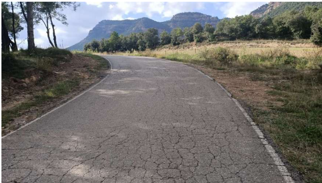
Tram 4 . Final actuacions en trams de paviment asfàltic (F9)
