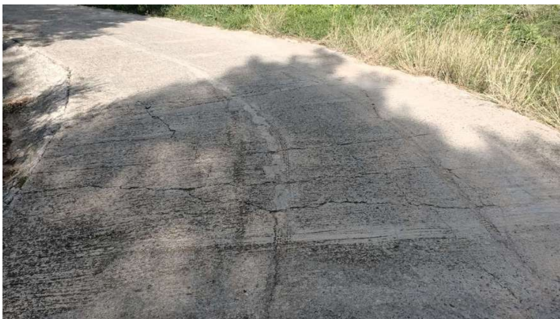
Tram 5. Inici reparacions en trams de paviment de formigó (F10)
