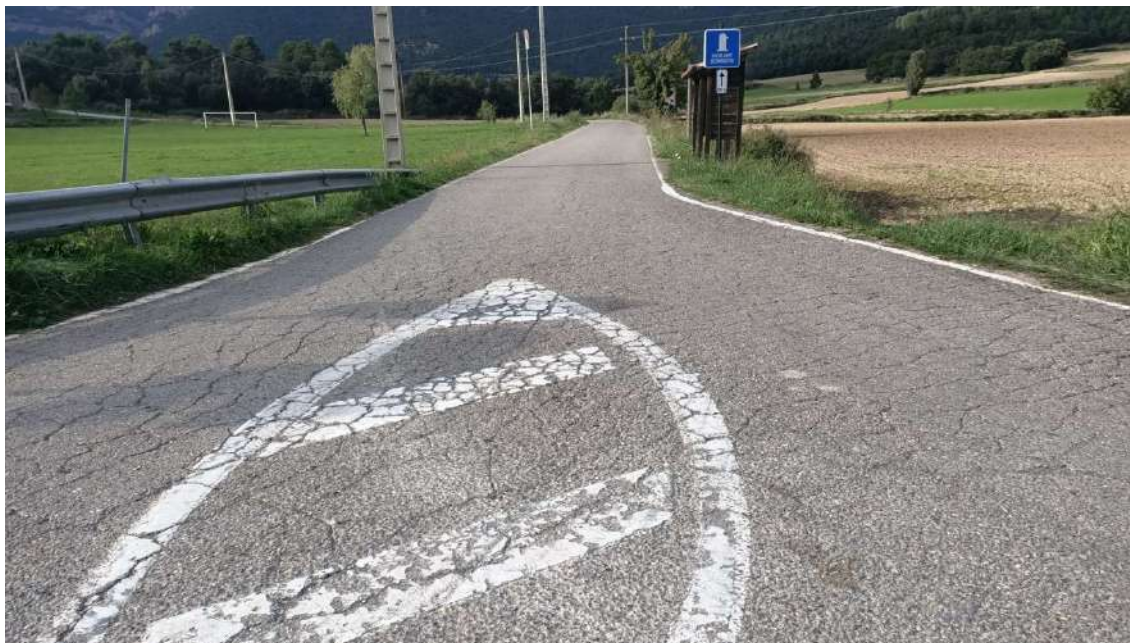
Tram 1. Inici reparacions en trams de paviment asfàltic (F1)
