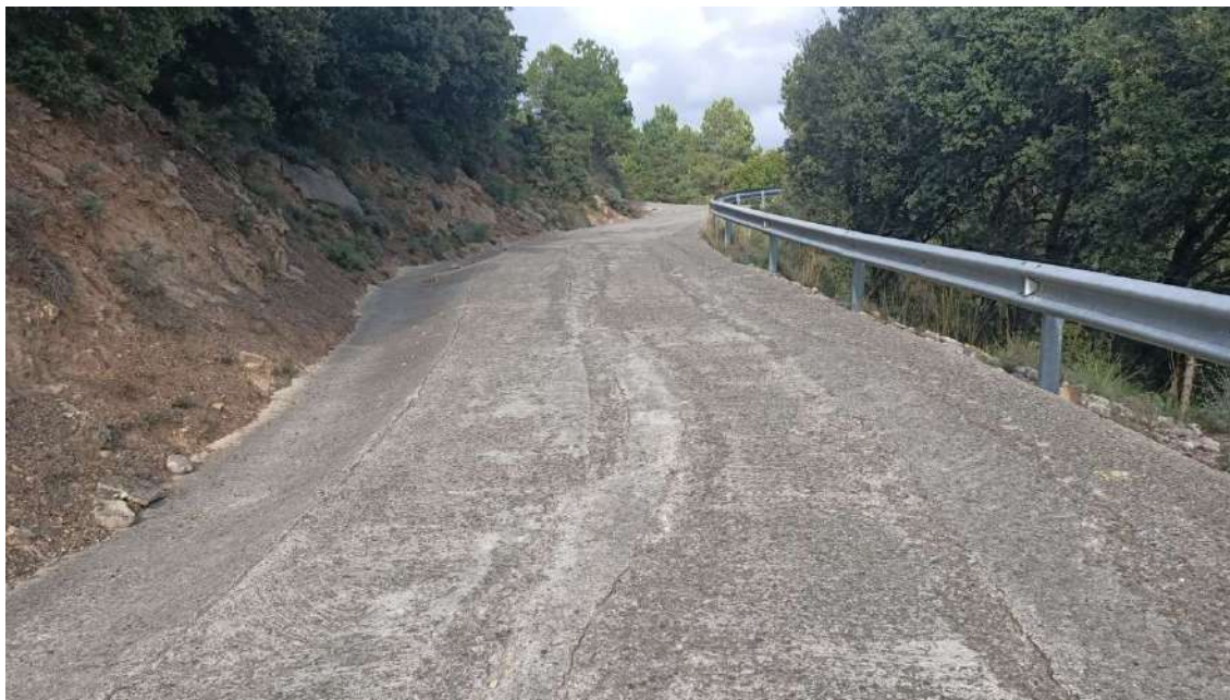
Tram 10 . Final reparacions en trams de paviment de formigó (F15)
