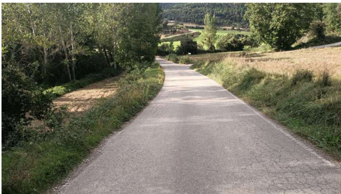
Zona a instal·lar barrera de seguretat de doble ona en el marge esquerre (F6)
