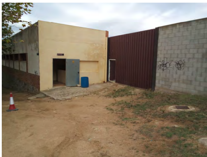
A la dreta, mur i porta a enderrocar.
