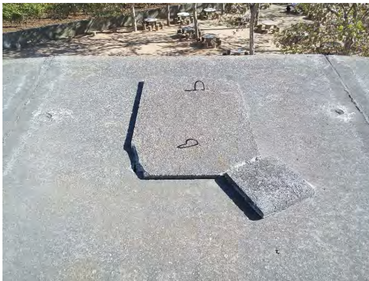
Accés actual a l'interior del dipòsit.
