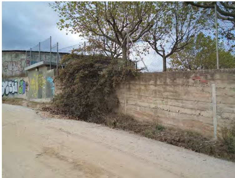
Tram de mur a enderroca, i on es situarà la porta d'entrada.
