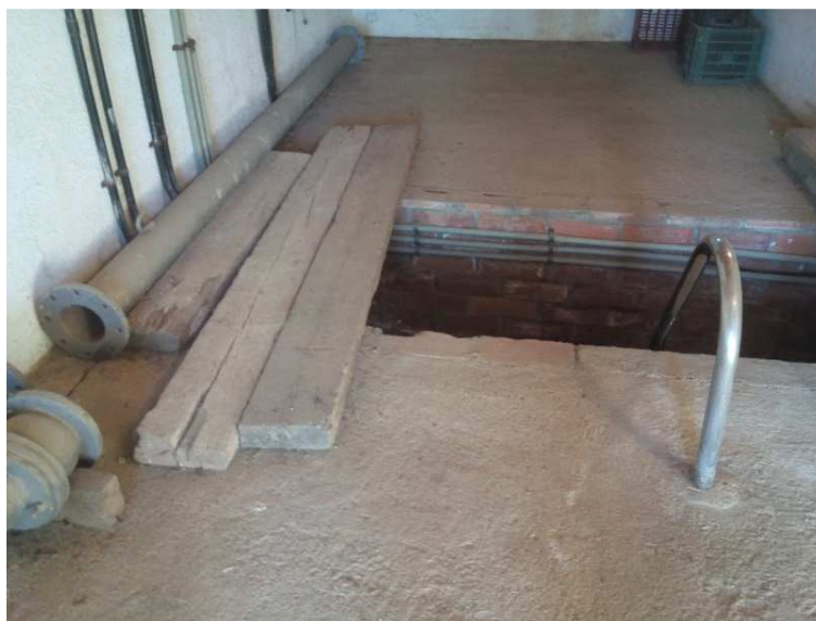
Vista del fossat de la cambra de quadres protegit per taulons.
