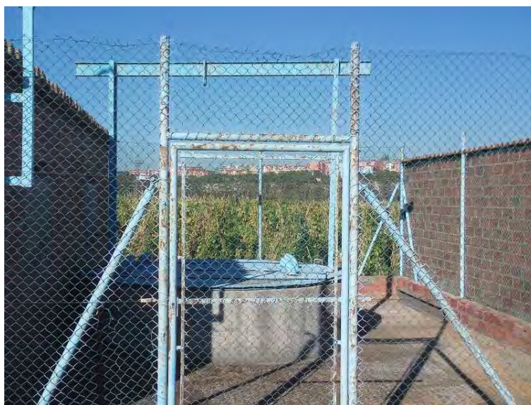
Coberta actual del POU 2
