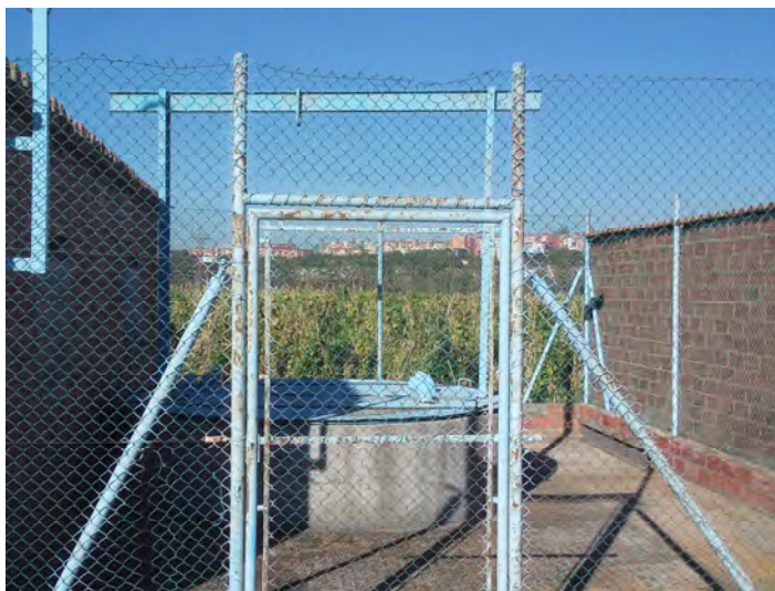
Coberta actual del POU 2
