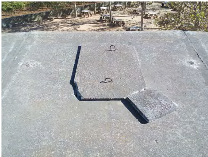
Accés actual a l'interior del dipòsit.
