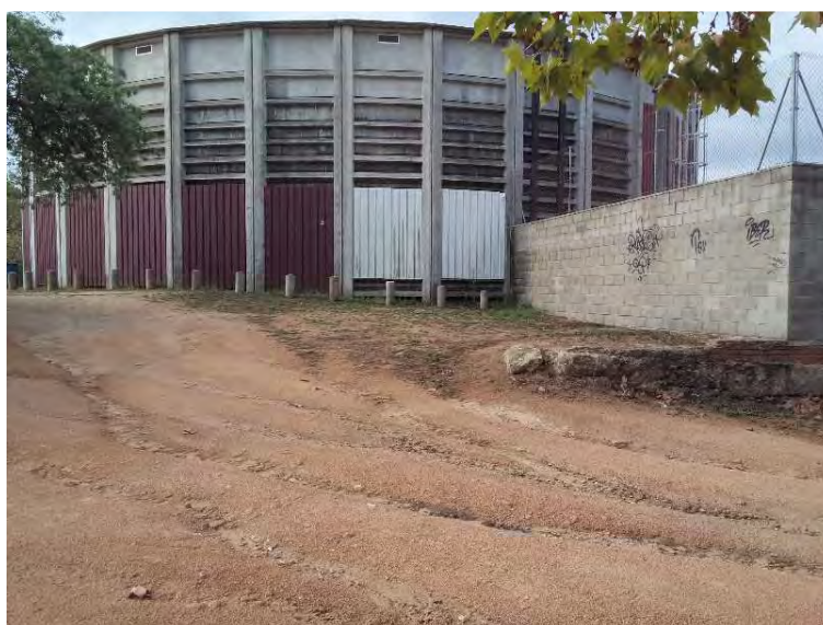
Mur a enderrocar parcialment.
