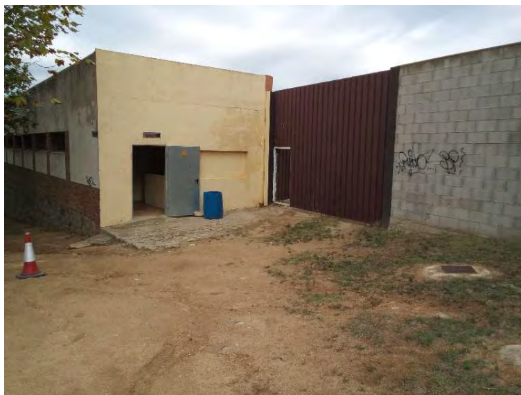
A la dreta, mur i porta a enderrocar.
