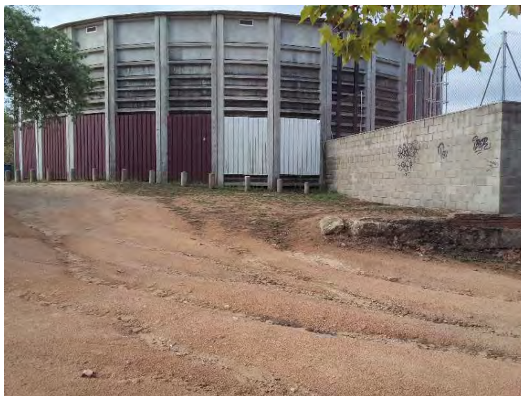
Mur a enderrocar parcialment.
