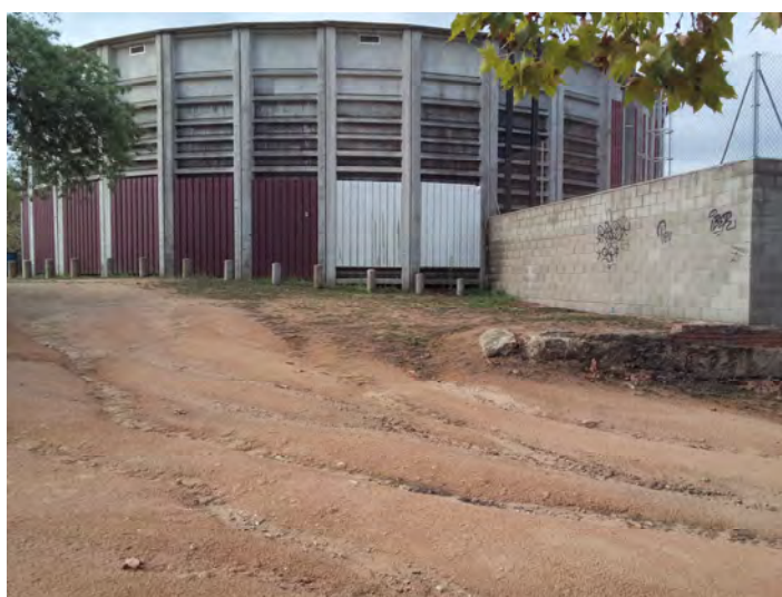
Mur a enderrocar parcialment.
