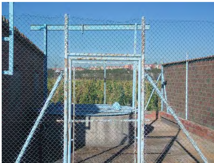
Coberta actual del POU 2
