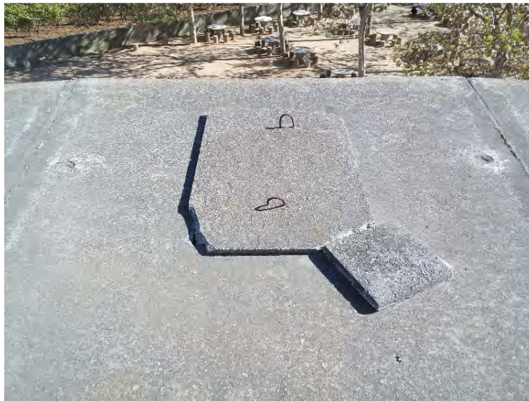
Accés actual a l'interior del dipòsit.
