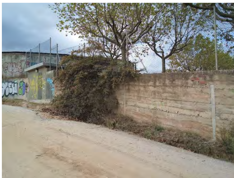
Tram de mur a enderroca, i on es situarà la porta d'entrada.
