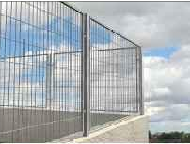
Tanca perimetral de 24.9 metres lineals amb porta incorporada. Alçada 2.50 metres.
