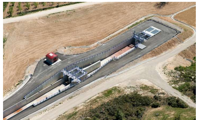
Tram 5: Obra de Regulació i entrada sifó de l'Esperiguera
