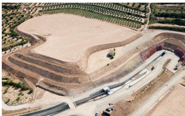
Tram 5: Entrada al túnel de Bessons (4.935 m)
