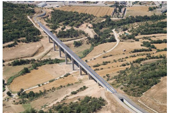
Tram 1 del Canal Segarra-Garrigues
