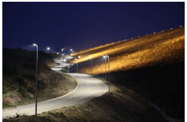
Il·luminació nocturna Presa de L'Albagés
