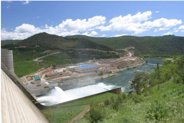
Presa de Rialb i Estació de Bombament del Canal Segarra-Garrigues
