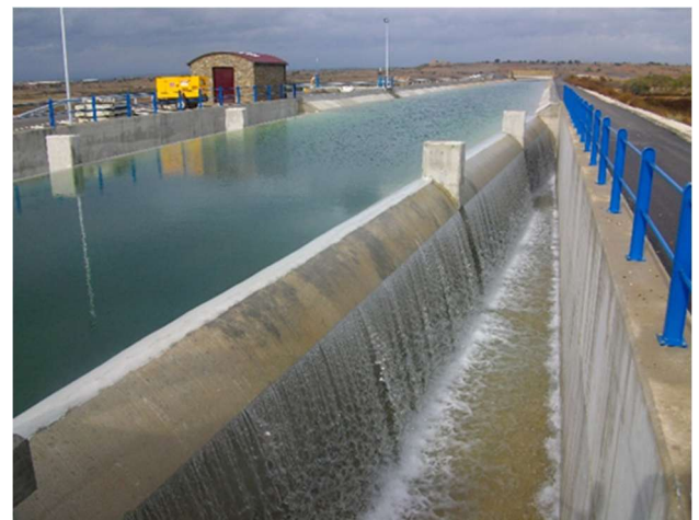
Tram 3 del Canal Segarra-Garrigues
