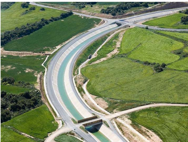
Tram 2B del Canal Segarra-Garrigues
