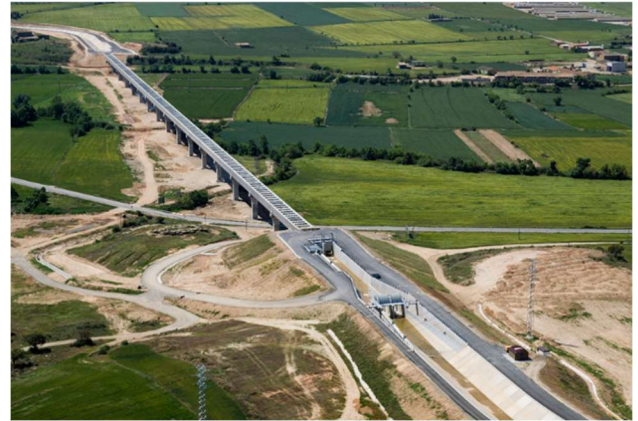
Tram 3: Aqüeducte del Canós i Obra de Regulació i presa de Reg S5
