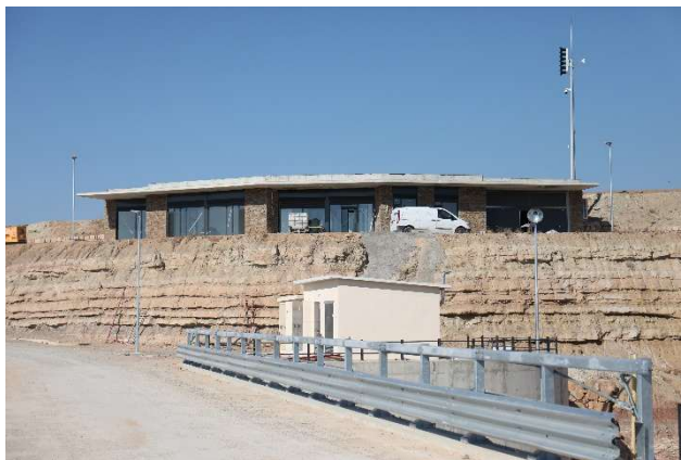
Edifici de control Presa de L'Albagés
