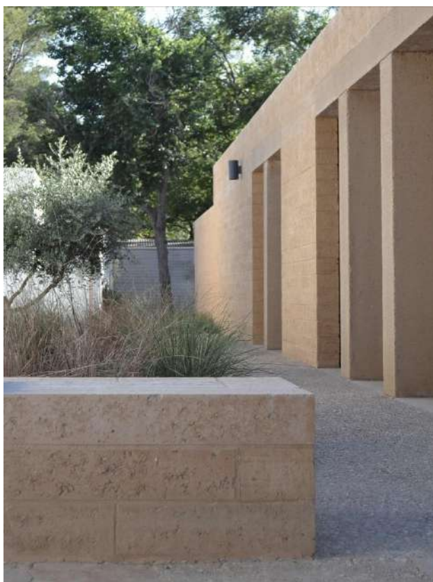
Exemple muret – banc fet amb bloc de terra compactada amb peça ceràmica a la part superior
