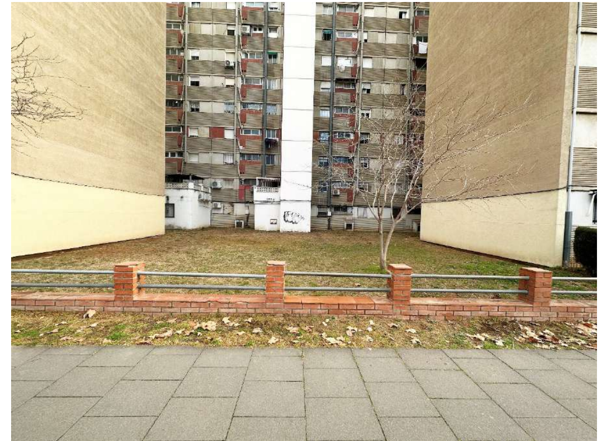
Vista dels espais verds situats enmig dels edificis perimetrals
