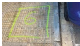
ENSAYO PERMEABILIDAD EN ZANJA
