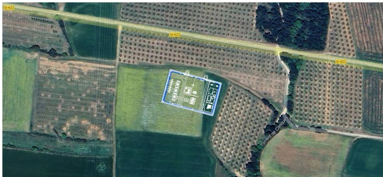
Figura 5. Vista de la carretera GI-622 al norte de la parcela prevista para la subestación
