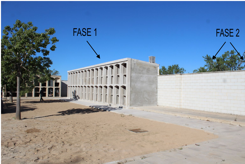
Vista de l'ampliació corresponent a la FASE 1 de l'any 2025. La FASE 2 es construirà al costat.
