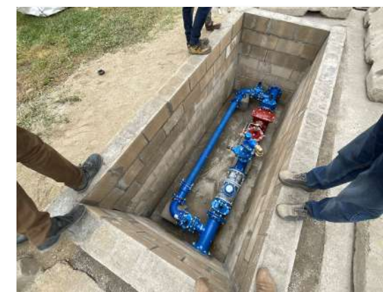
Imatge d'instal·lació tipus de reguladora
