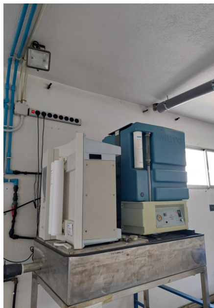
Detall del dipòsit-bomba d'impulsió i equip de producció d'aigua de grau analític
