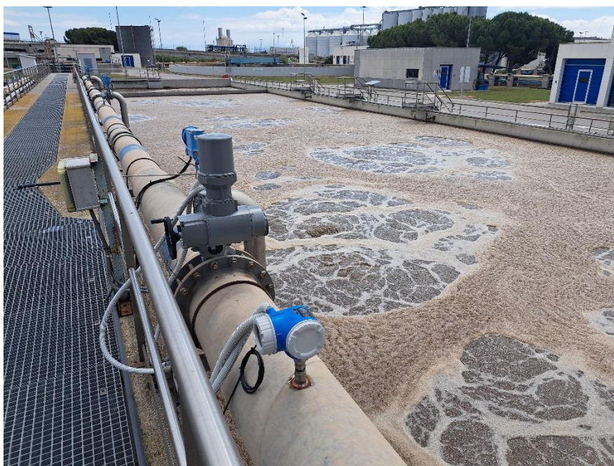
Foto núm. 2: Vista de la línia d'aire i del cabalímetre indicador del cabal total a mantenir
