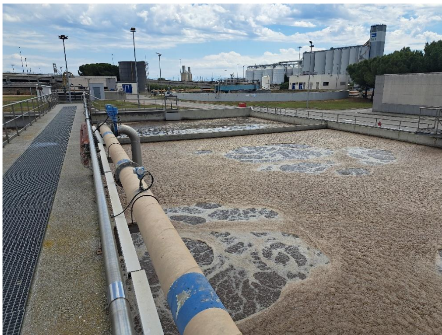
Foto núm. 4: Vista de la línia d'aire i del cabalímetre indicador del cabal parcial a substituir
