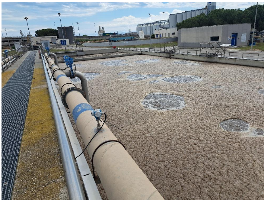
Foto núm. 3: Vista de la línia d'aire i del cabalímetre indicador del cabal parcial a substituir
