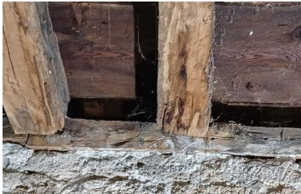
Figura 16. NN_CAB_11. Pèrdua de secció de 40 mm des del cap nord fins a 300 mm per podridura bruna
