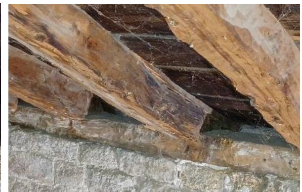
Figura 19. NN_CAB_20. Pèrdua de secció de 30 mm al cap nord per podridura bruna
