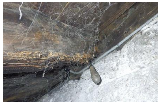
Figura 25. NS_CAB_27. Pèrdua de secció de 40 mm des del cap nord fins a 300 mm per podridura bruna
