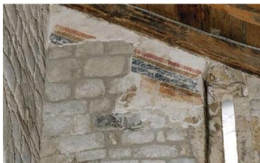
Detall de la relació entre sanefes pictòriques i bigues de vessant a la capçalera de les naus laterals (Fotos R. Ramos, a Marqués 2016)
