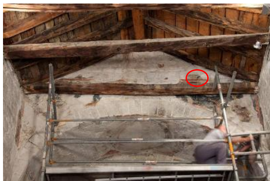
Procés de desmuntatge del tirant més proper a l'arc preabsidal i gràfic interpretatiu de les restes pictòriques. Notis (encerclada en vermell) la presència de la pota anterior d'un quadrúpede per sobre de la sanefa geomètrica
