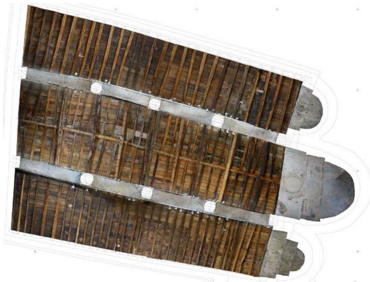
Figura 7. Vista zenital de tot l'entramat de cabirons
