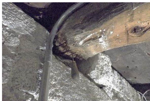
Figura 14. NN_CAB_05. Pèrdua de secció de 30 mm al cap sud per podridura bruna
