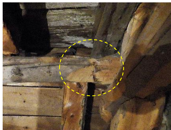
Figura 13. Carener CAR02, poc recolzament al cap oest
