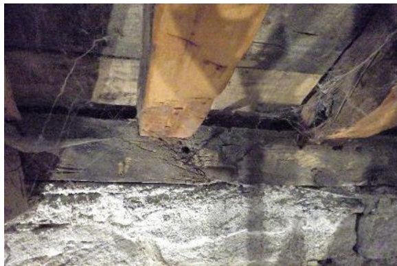
Figura 22. NC_N_CORS_N_3002. Pèrdua de secció de 20 mm des del cap oest fins a 800 mm per podridura bruna.
