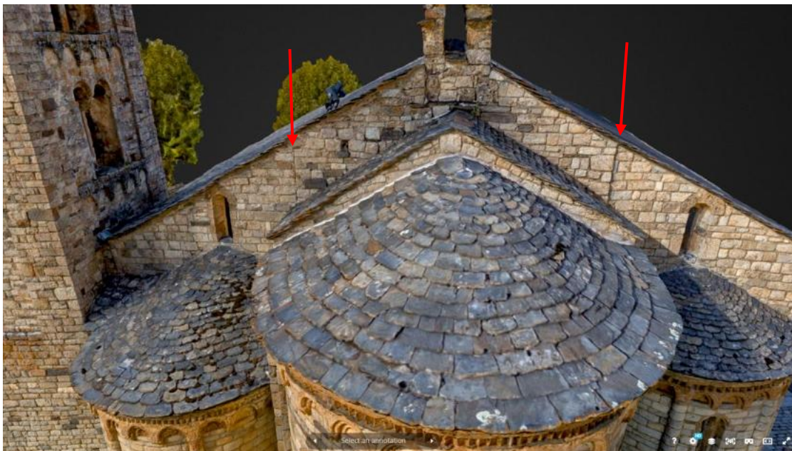
Imatge del coronament de la capçalera amb indicació de les juntes constructives (fletxes vermelles), indicatiu de que les naus laterals s'haurien adossat a la nau central durant la Fase III (Foto: Giravolt)
