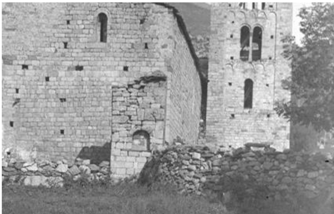
Detall d'una imatge de 1907, quan la junta entre campanar i façana Sud de l'església encara està oberta (Foto: Arxiu Mas)
