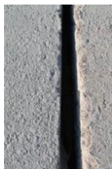
Figura 50. Tall típic de micro-rasa
