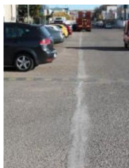
Figura 54. Rasa finalitzada amb formigó.
