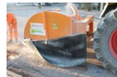
Figura 49. Exemple d'una rasadora en funcionament.
