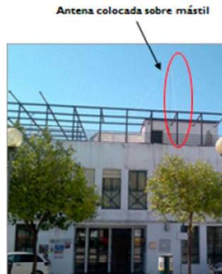
Antena colocada sobre mástil
