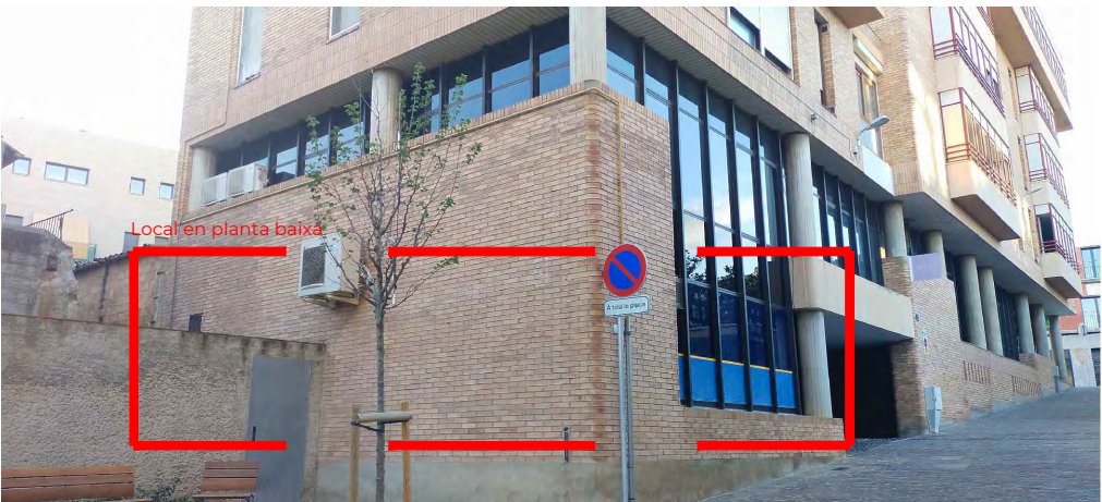
Vista general de les 2 façanes
