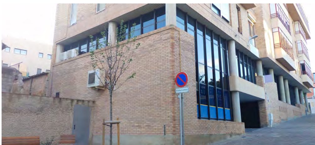
Cantonada façana nord (antic carreró de les Puces) amb façana a la Plaça de la Vila.
