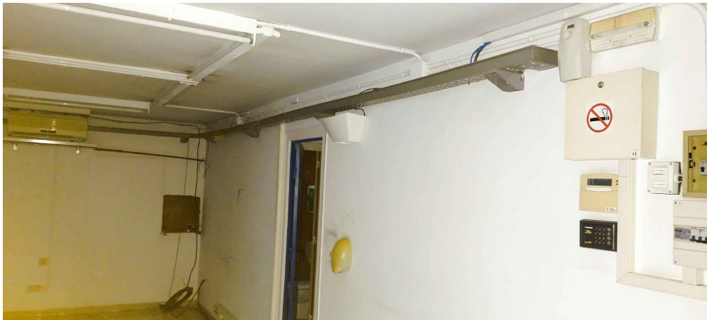
Interior sala principal - accés distribuïdor
