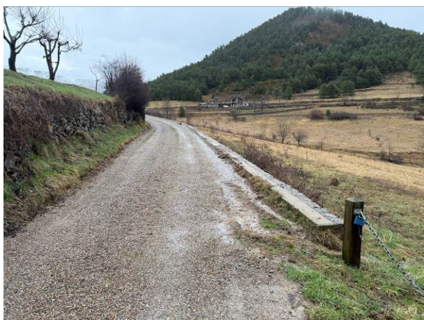
Foto 3. Traçat conducció a renovar
