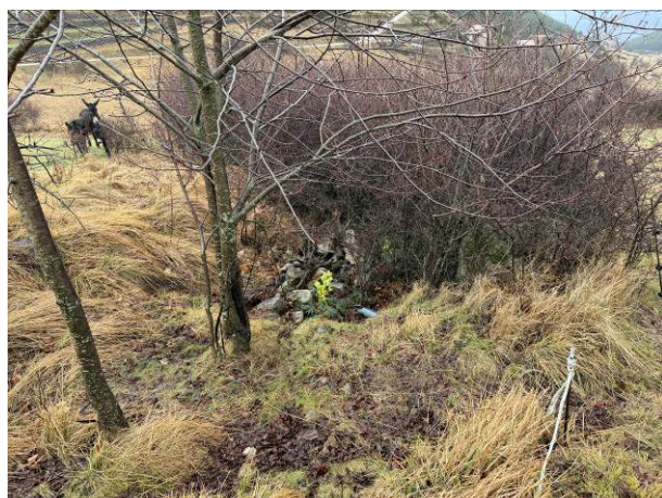
Foto 10. Traçat conducció a renovar
