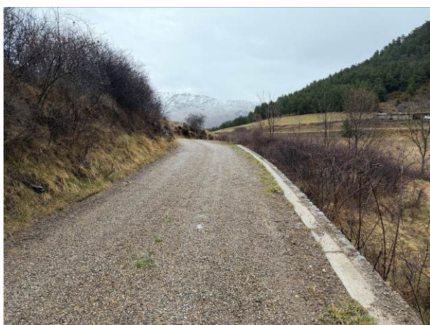
Foto 5. Traçat conducció a renovar
