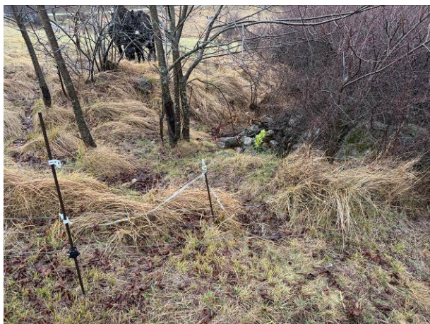
Foto 9. Traçat conducció a renovar
