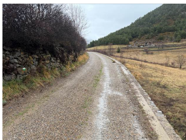
Foto 4. Traçat conducció a renovar
