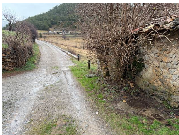
Foto 2. Hidrant existent i traçat conducció a renovar
