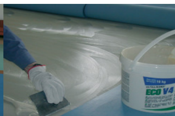
Aplicación de Ultrabond Eco V4SP - Casa de reposo San Martino - Italia
