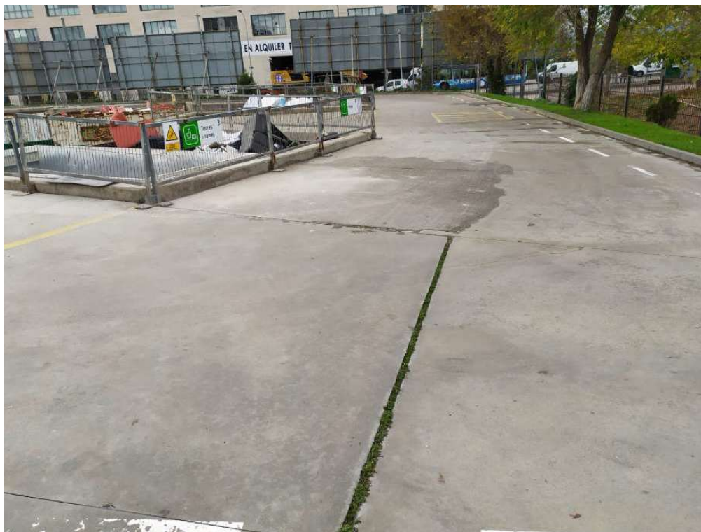
Fotografia juntes obertes en molls de carrega
