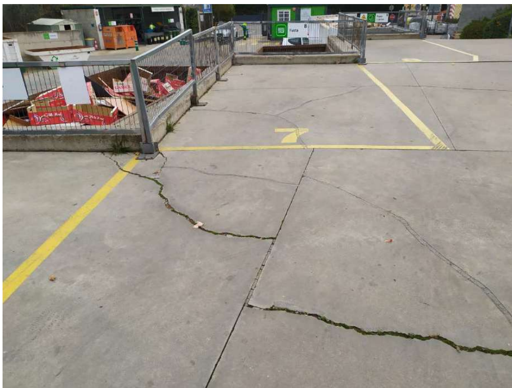
Fotografia juntes obertes en molls de carrega
