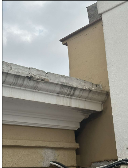
REPARACIÓ DE LA CORNISSA
