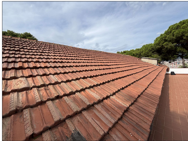
REPARACIÓ DE LA COBERTA
