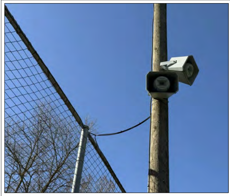
D4 D603D604 DESCONNEXIÓ, DESMUNTATGE I RECOL.LOCACIÓ D'ALTAVEUS
