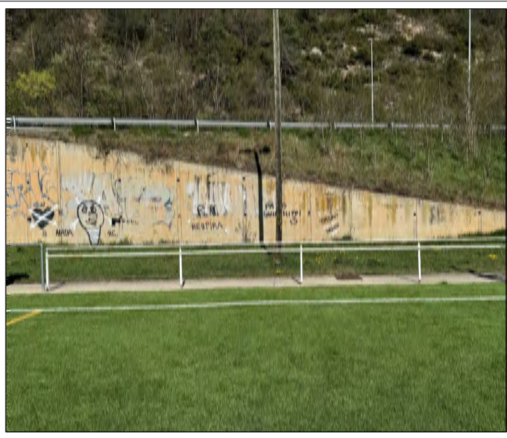
D2 D603D604 DESMUNTATGE DE BARANA PERIMETRAL
