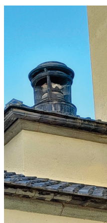
Edifici Marina. Xemeneia existent Campus Torribera
