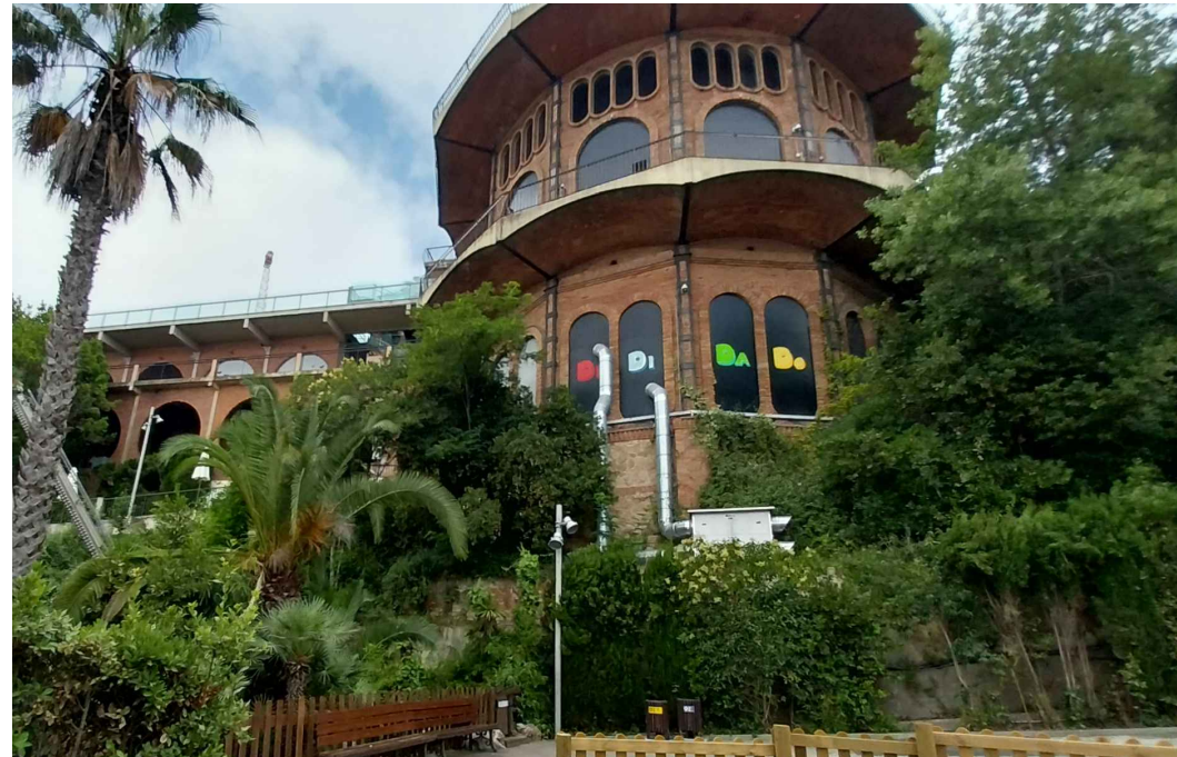
Estat actual instal.lació clima
