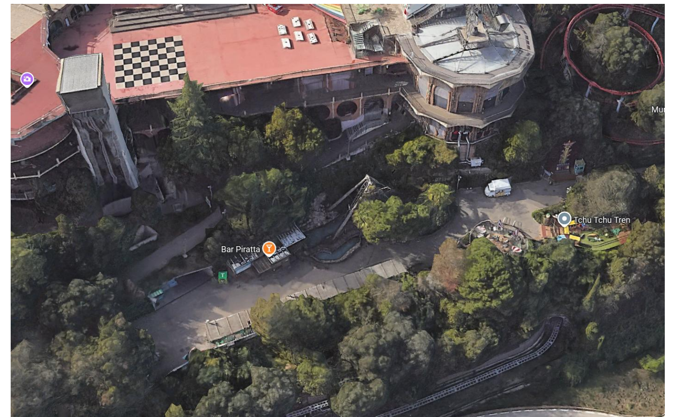
Fig. 2 Vista aèria zona d'actuació
