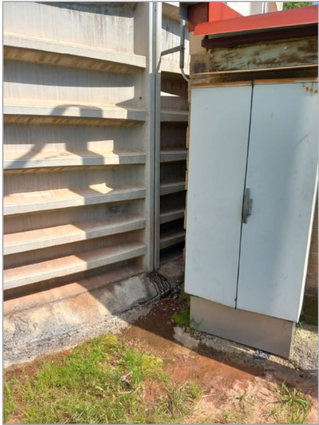
Fig. 20 i 21. Afectacions fuites paraments verticals i juntes del dipòsit.
