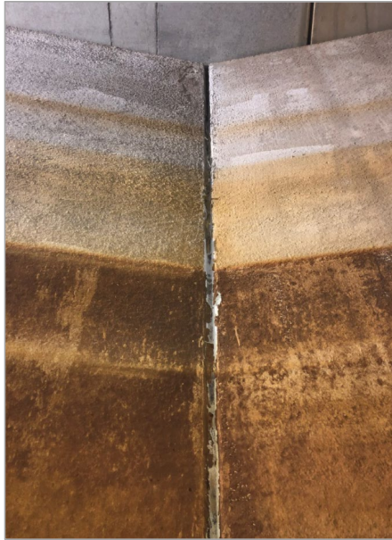
Fig. 13 i 14. Vista paraments verticals del dipòsit on es pot veure afectacions segellat plaques
