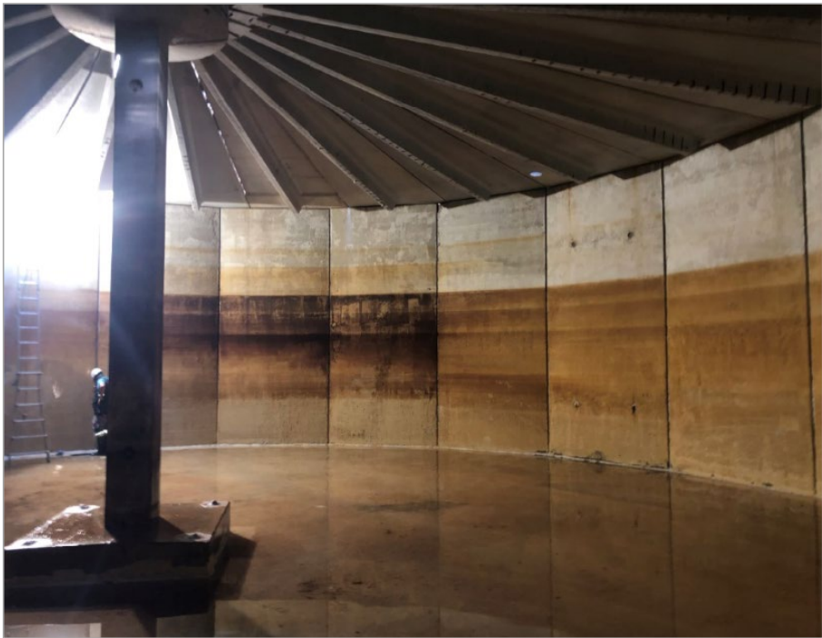
Fig. 10. Vista general del dipòsit on es pot veure el pilar central.
