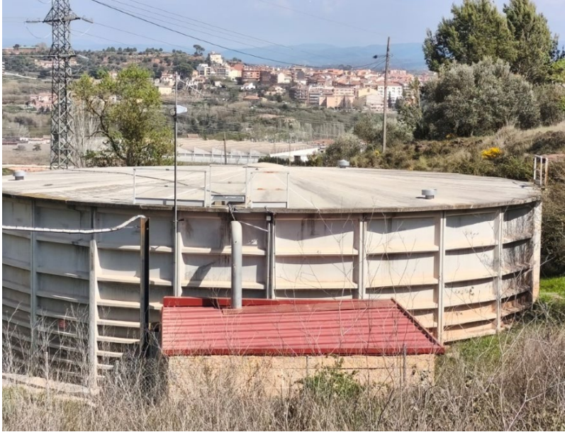
Fig. 8: Imatge coberta de l'exterior del dipòsit
