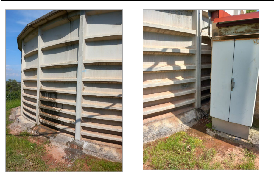
Fig. 7: Imatges paraments verticals de l'exterior del dipòsit
