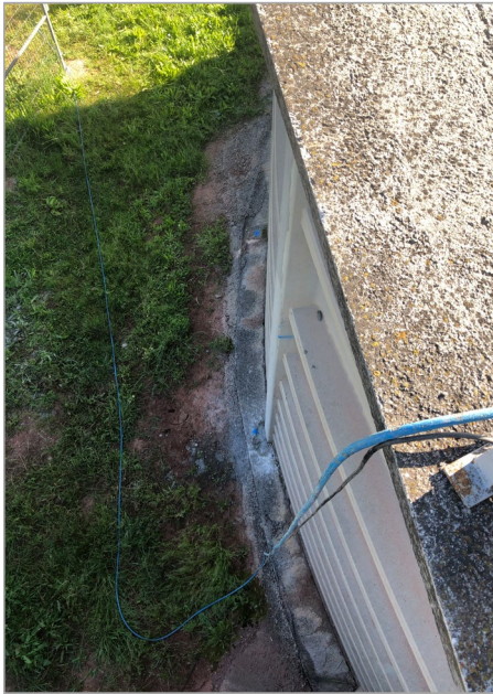
Fig. 22 i 23. Afectacions fuites paraments verticals i juntes del dipòsit.
