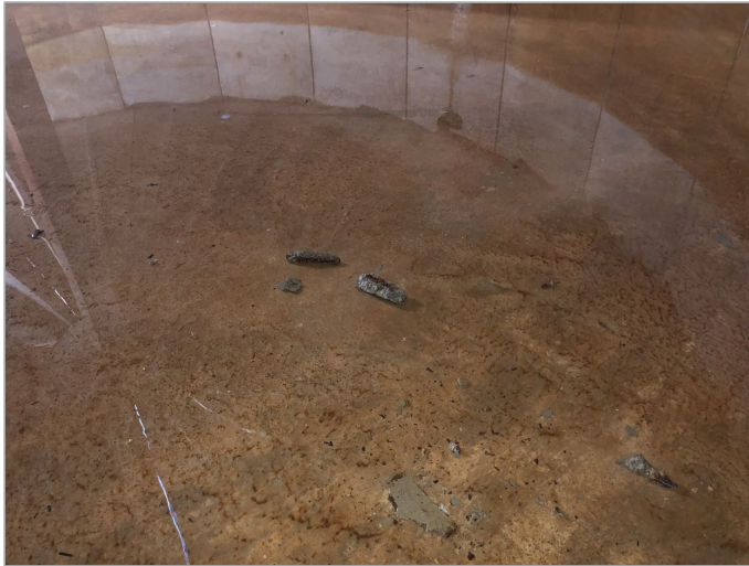
Fig. 8. Vista despreniment de peces de formigó al fons del dipòsit i detall peça formigó despresa.
