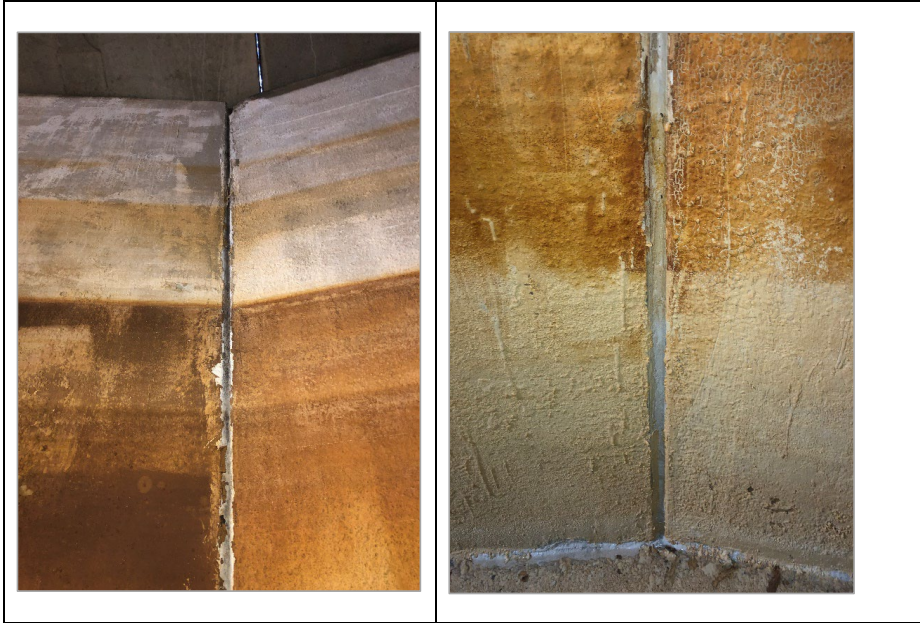
Fig. 6: Imatges paraments verticals a l'interior del dipòsit
