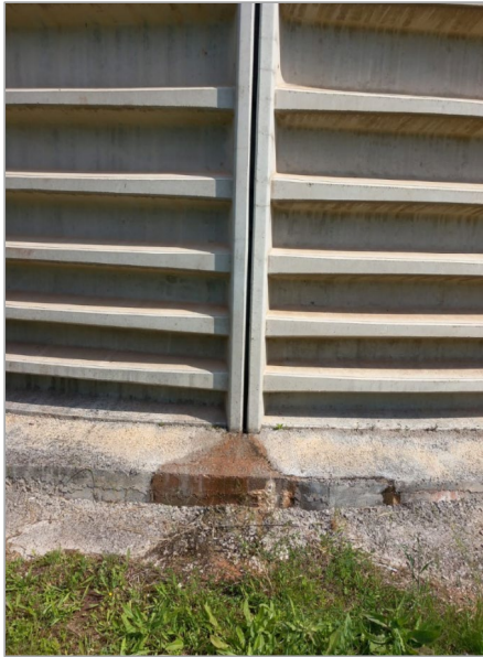
Fig. 20 i 21. Afectacions fuites paraments verticals i juntes del dipòsit.
