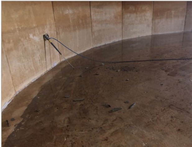
Fig. 9. Vista despreniment de peces de formigó al fons del dipòsit i detall peça formigó despresa.
