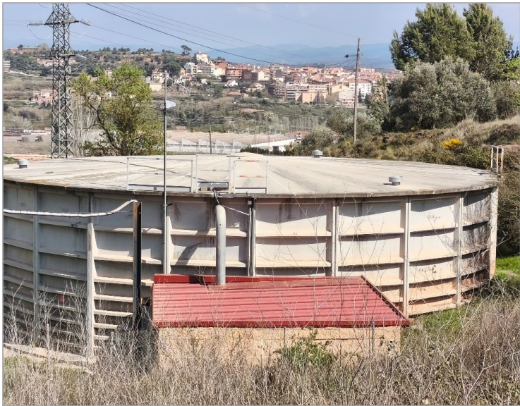
Fig. 17. Vista coberta de dipòsit Pont Nou
