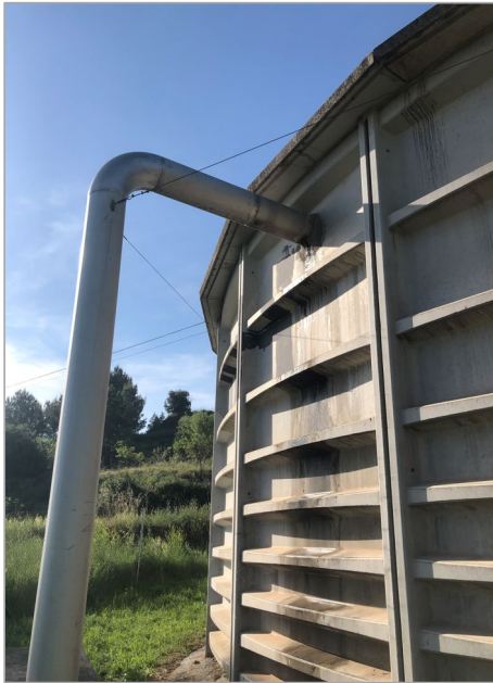
Fig. 22 i 23. Afectacions fuites paraments verticals i juntes del dipòsit.
