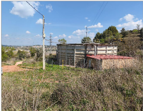
Fig. 16. Vista general dipòsit Pont Nou
