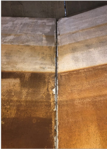
Fig. 13 i 14. Vista paraments verticals del dipòsit on es pot veure afectacions segellat plaques
