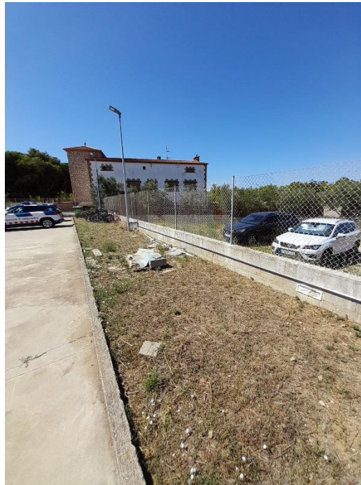
Mur posterior exterior de la Comissaria dels Mossos d'Esquadra de Roses
