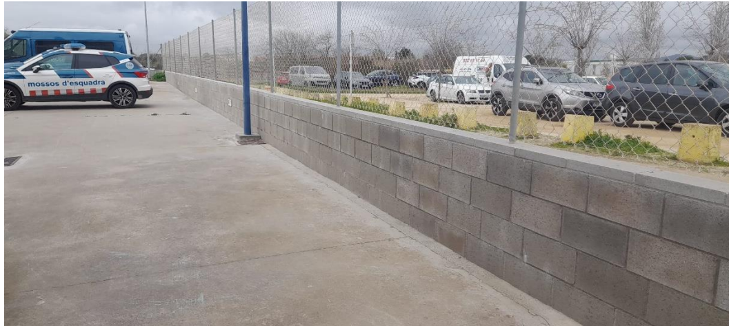
Mur posterior exterior de la Comissaria dels Mossos d'Esquadra de Roses Carretera Arenas, 49 Girona
