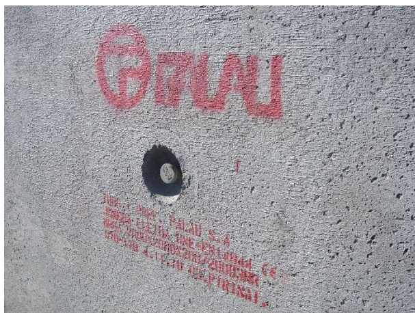
Anclaje tipo DEHA
