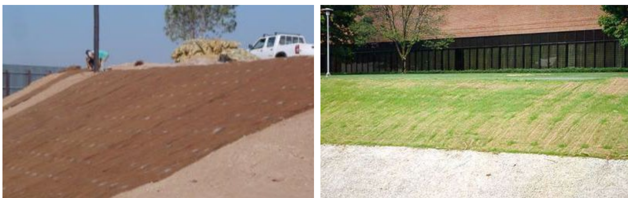
Figura 34 Exemple de talussos amb manta orgànica.
