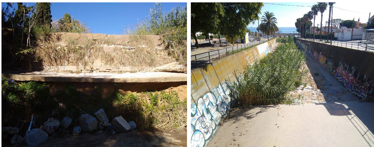
Figura 8 (Esquerra) Travessa de formigó transversal a la llera. (Dreta) Riera endegada.
