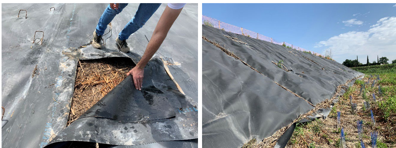
Figura 31 Exemple de col·locació de làmina de plàstic en talús. En aquest cas es preveu col·locar ret de coco per sobre per tal de minimitzar l'impacte visual
