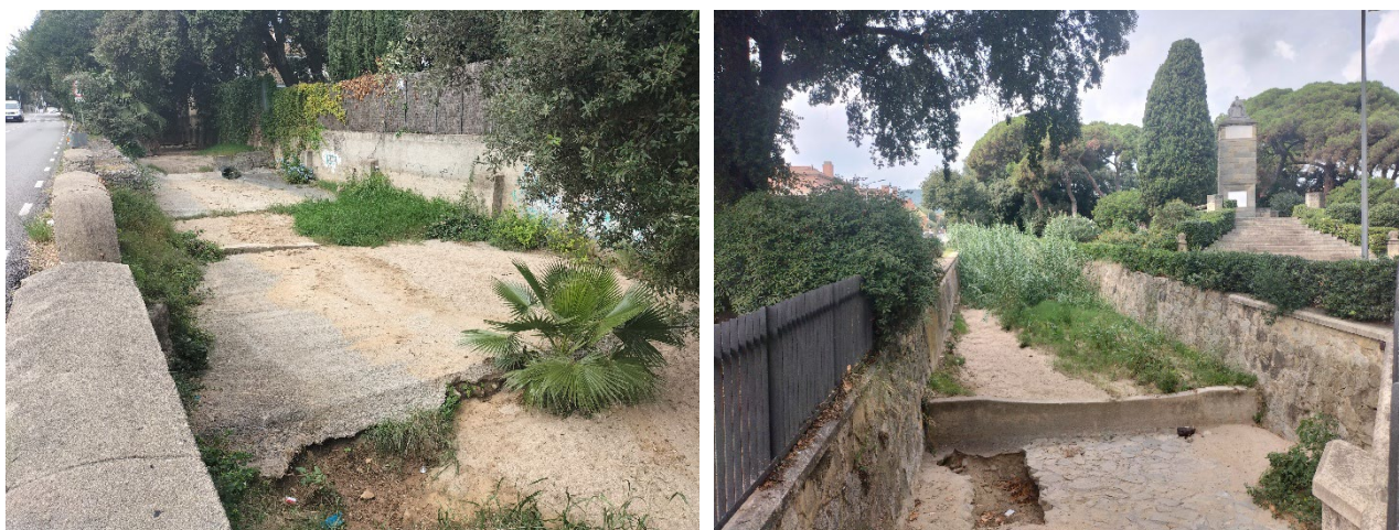
Figura 9 (Esquerra) Llera parcialment formigonada (vista aigües amunt). (Dreta) Tram delimitat per murs previ al soterrament per sota de la carretera BV-5035 (vista aigües avall).
