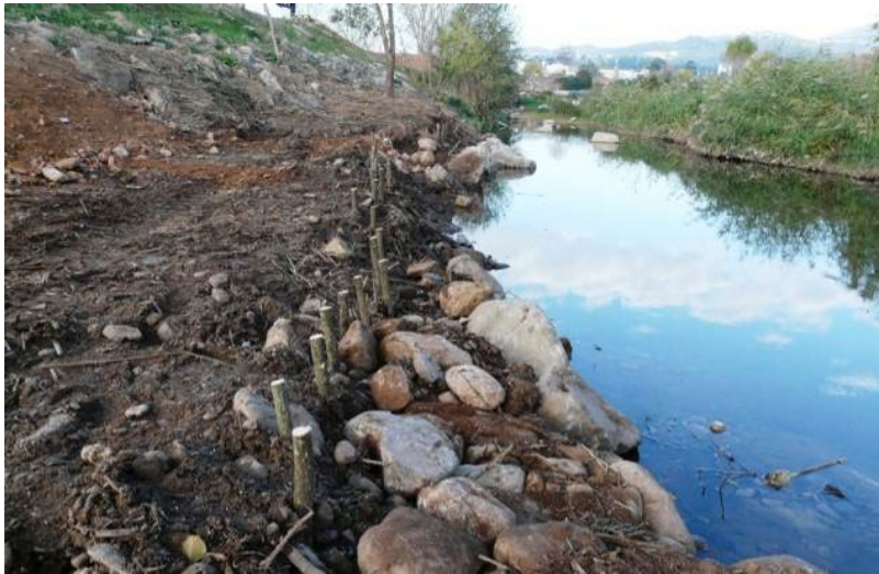
Figura 38 Plantacions d'estaques en un marge fluvial
