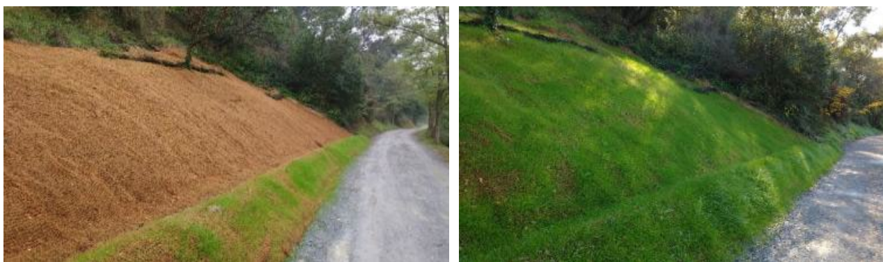
Figura 35 Procés evolutiu d'un talús amb ret de coco.
