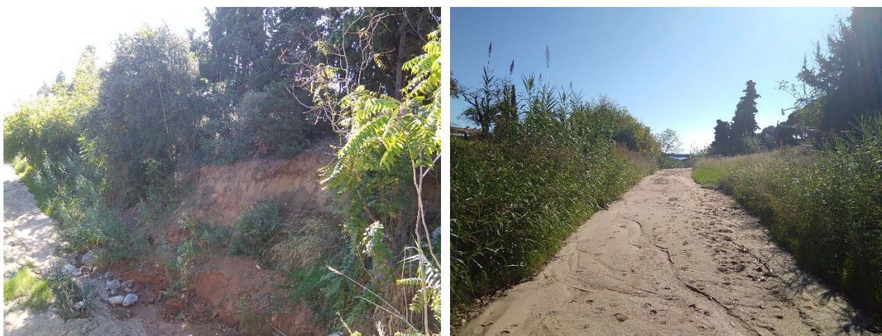
Figura 5 (Esquerra) Talussos amb pendents pronunciades i importants desnivells. (Dreta) Talussos amb pendents suaus i poc desnivell.
