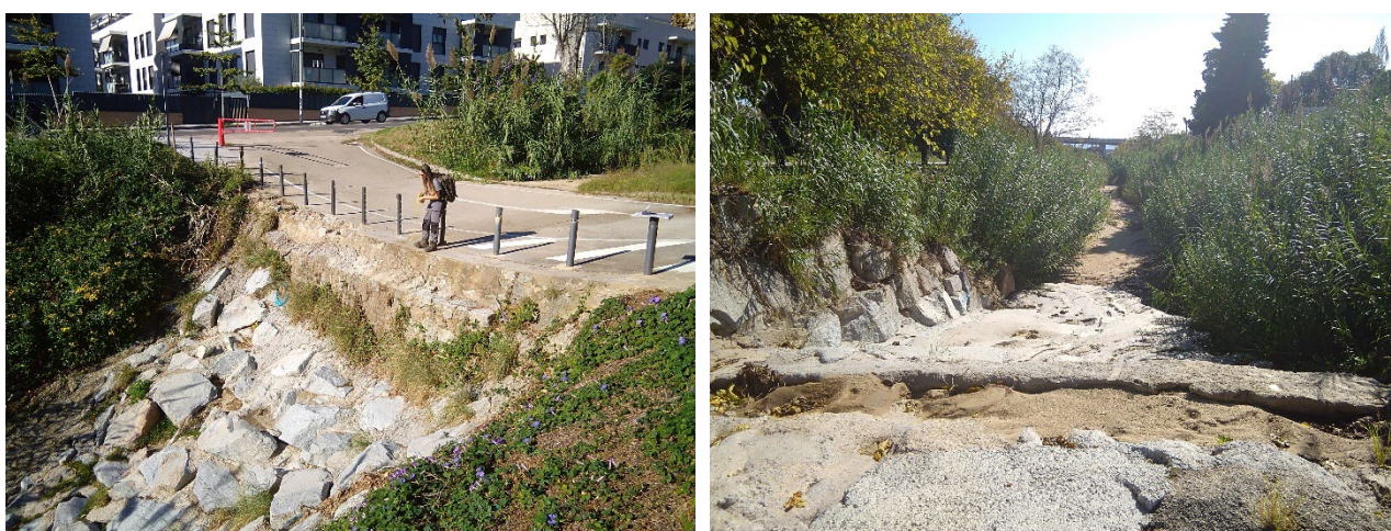
Figura 7 (Esquerra) Escullera a continuació d'un creuament. (Dreta) Presència de formigó i escullera a la llera i laterals de la riera.
