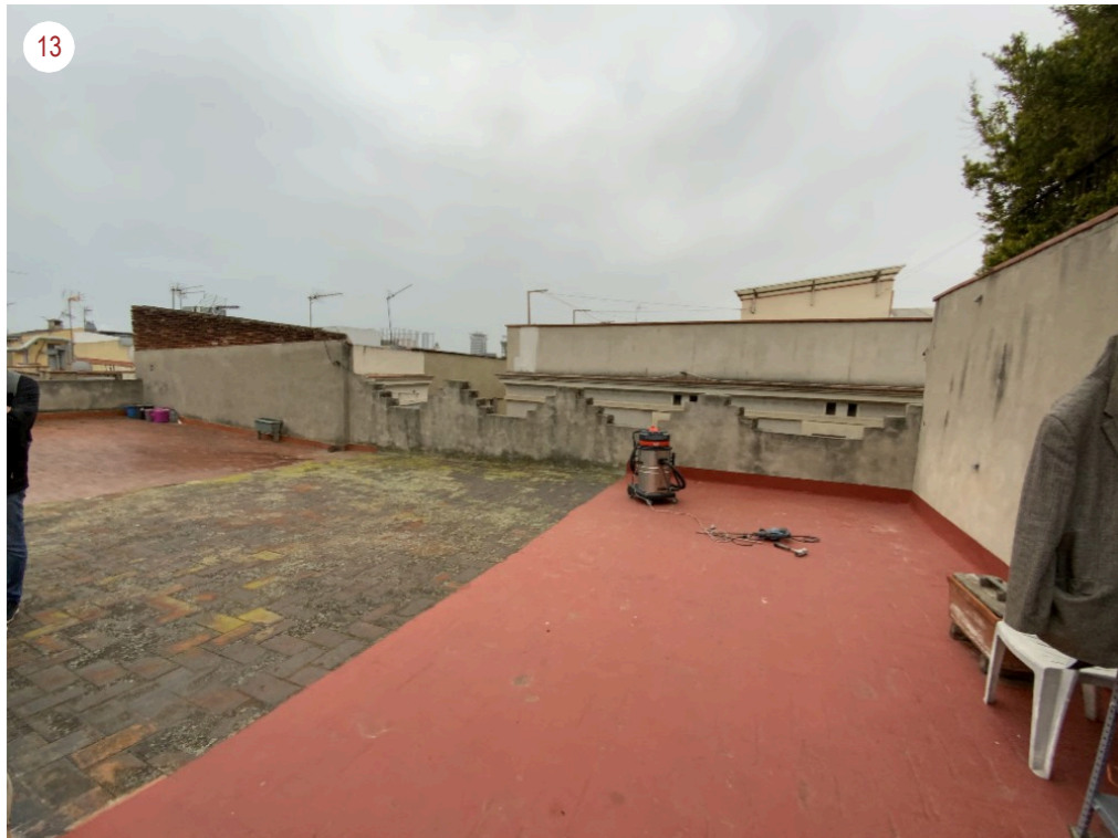
TERRAT. CORONAMENT FAÇANA CARRER PARADÍS
