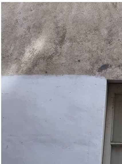
Fotografia de detall per identificar el parament amb el lliscat de calç amb una zona pintada amb posterioritat.
