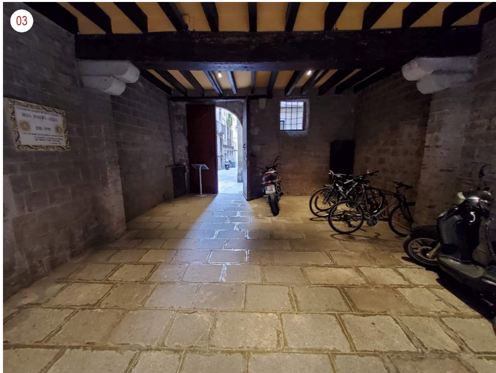
03 VESTÍBUL ACCÉS EDIFICI
