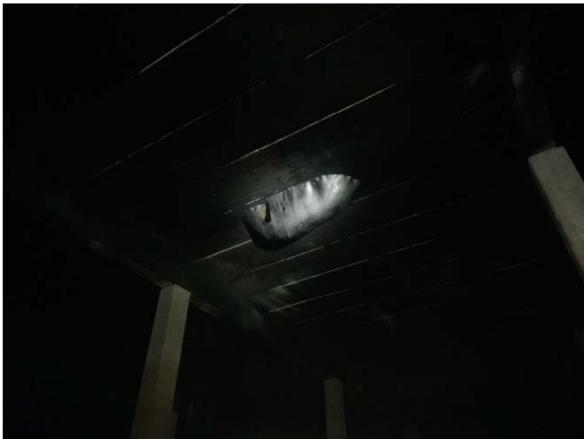
Vista butllofa de material impermeabilitzat de la coberta
