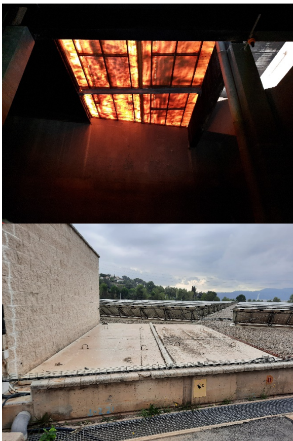
Obertura a la coberta per accés de maquinària
