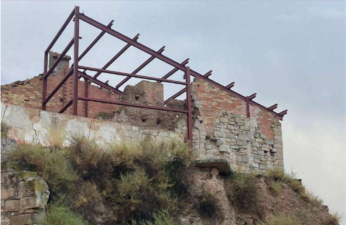
Vista general de l'estructura i subestructura metàl·lica col·locada en la torre del Castell
