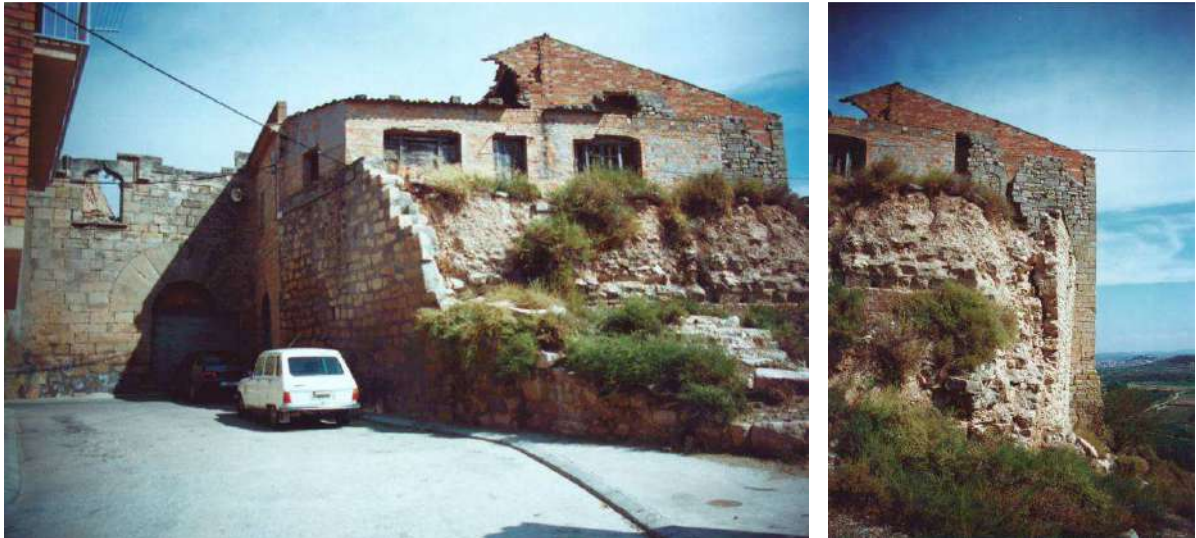
Vistes antigues del Castell, costats oest (Font: Inventari Patrimoni Arquitectònic)
