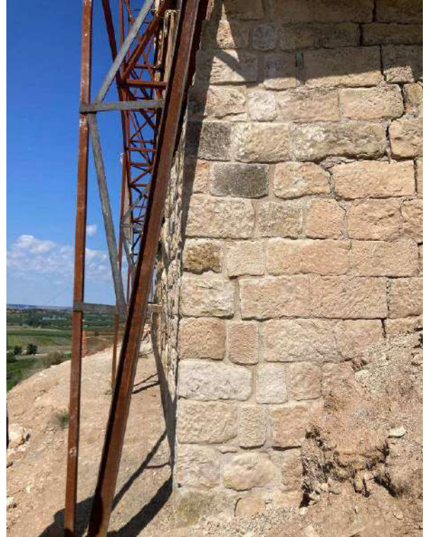
Reconstrucció de la cantonada sud-est de mur de carreus
