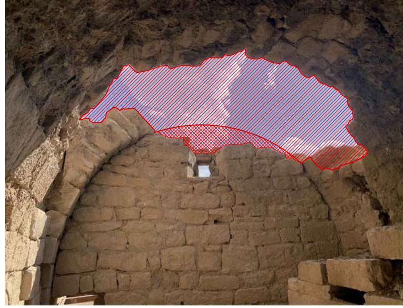
Volta 1 adossada a la torre: reconstrucció de la volta i un petit tram de mur sota la clau
