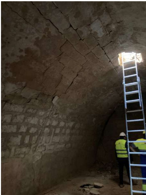
Volta soterrani torre. Esquerdes i moviments estructurals importants
