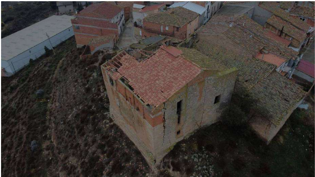
Vista aèria més recent (Font: Inventari Patrimoni Arquitectònic)
