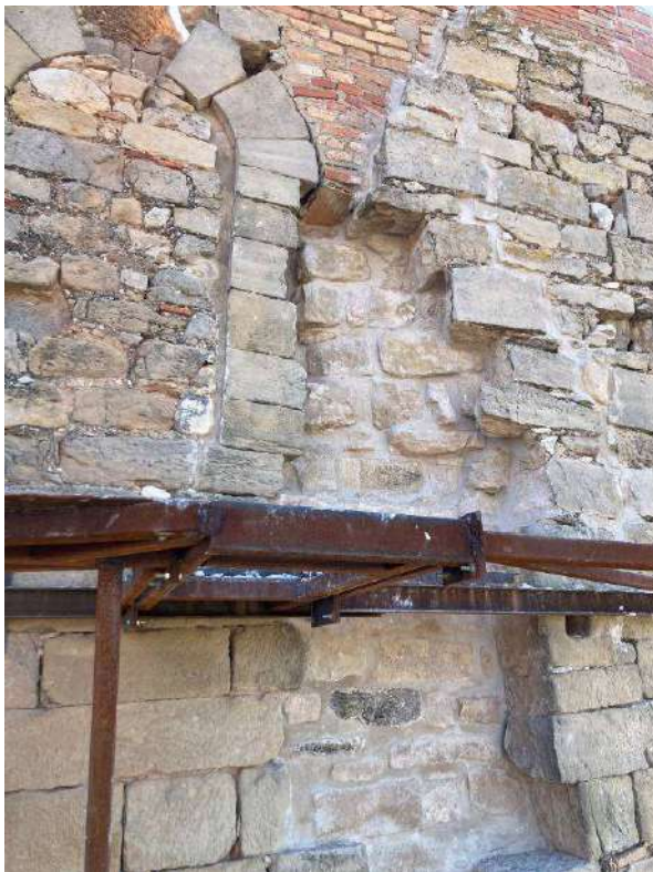
Detall del segellat de consolidació inicial
