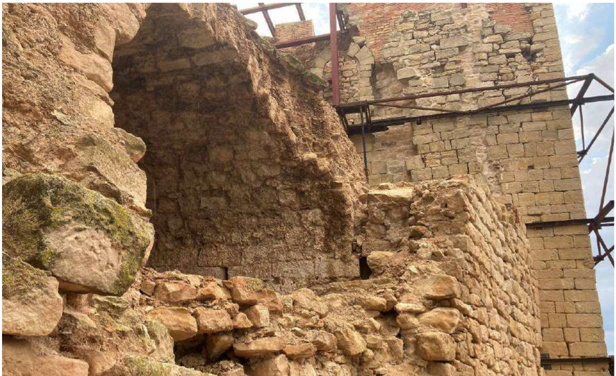
Tram de mur desmuntat per seguretat
