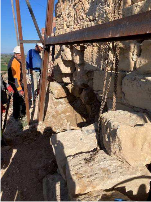
Reconstrucció del tram oest de la façana sud de la torre
