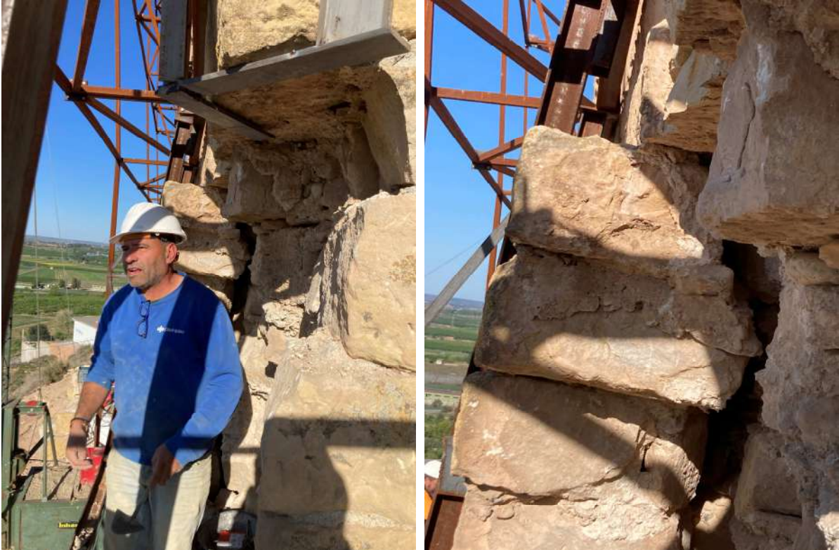
Reconstrucció del costat est del mur sud de la torre del Castell
