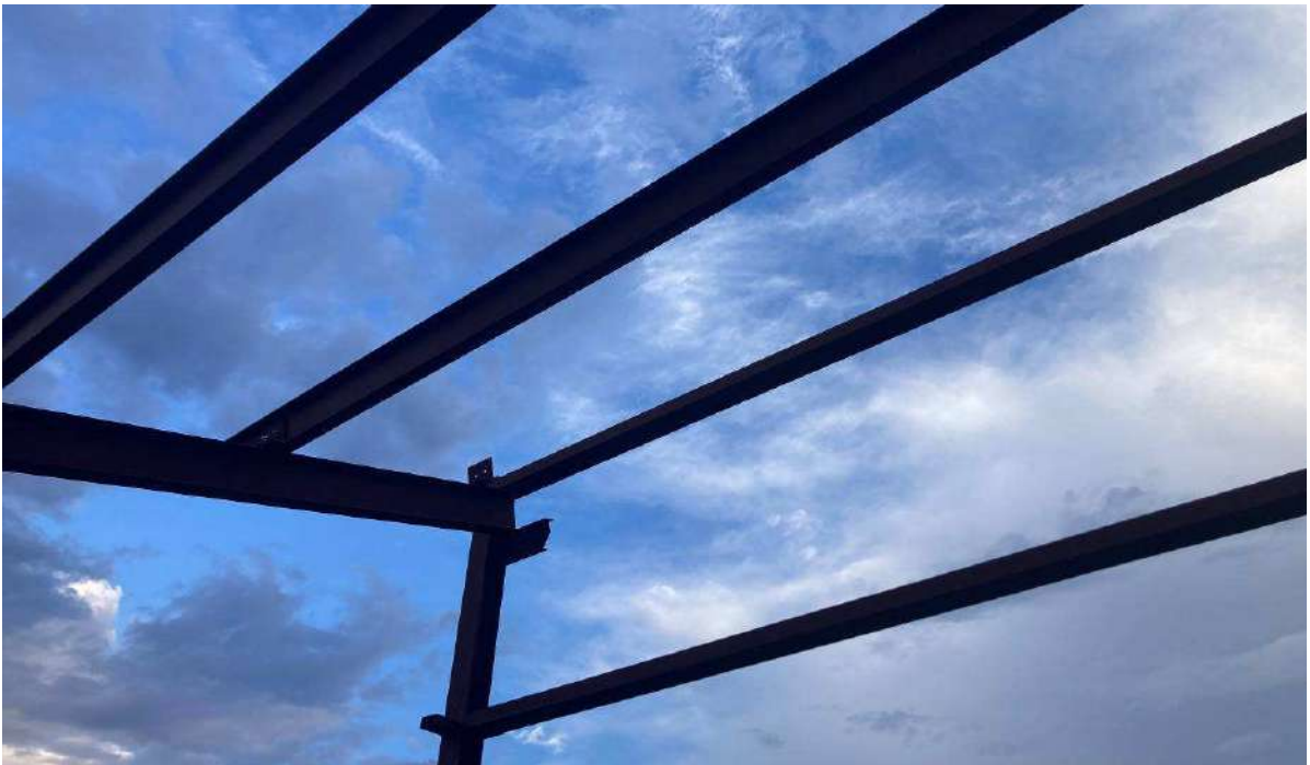
Estructura i subestructura de suport de la coberta i laterals provisionals de protecció
