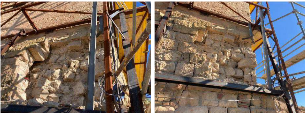
Vistes generals de la reconstrucció del costat est del mur sud de la torre del Castell
