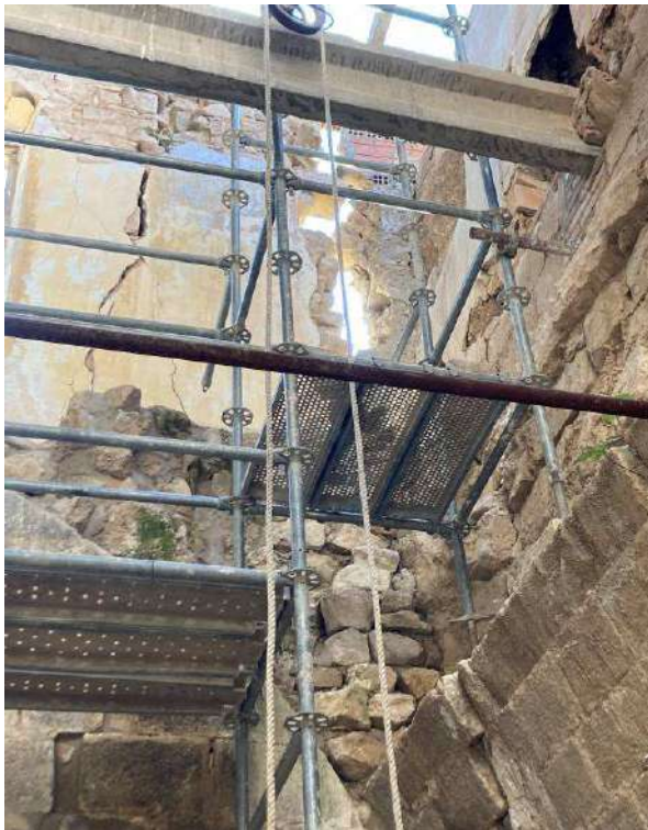
Reomplert i segellat d'esquerdes i separacions en l'interior de la façana est
