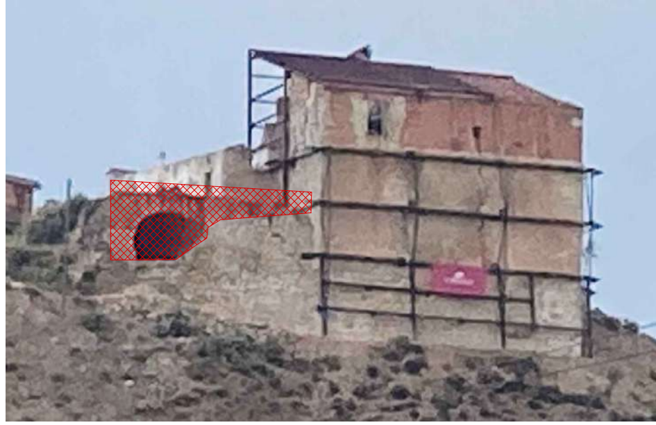
Vista general de la façana sud, indicant el tram de mur a reconstruir
