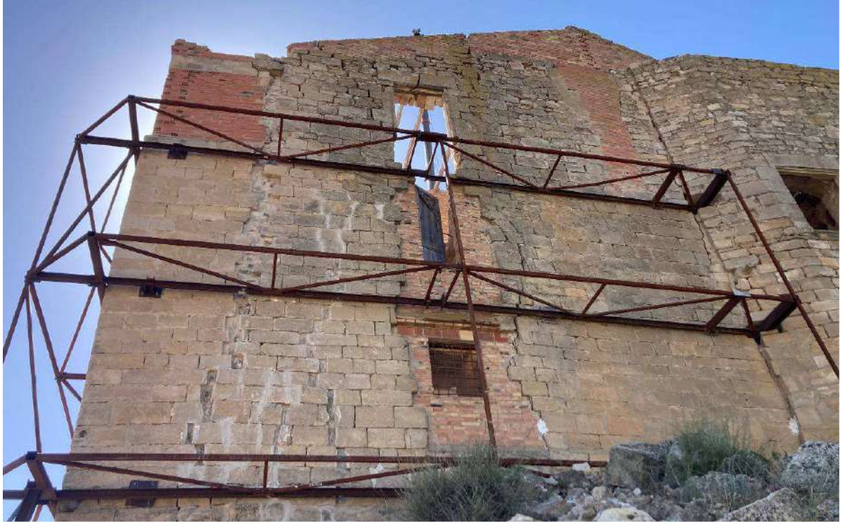
Reomplert i segellat d'esquerdes i separacions en façana est
