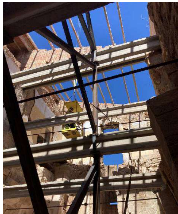
Enderroc de la coberta a substituir
