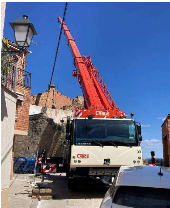
Enderroc de la coberta a substituir
