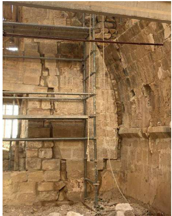
Reomplert i segellat d'esquerdes i separacions en l'interior de la façana est
