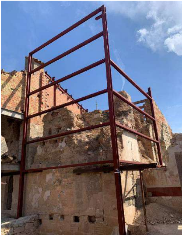
Muntatge de subestructura dels panys laterals a cobrir provisionalment amb xapa metàl·lica
