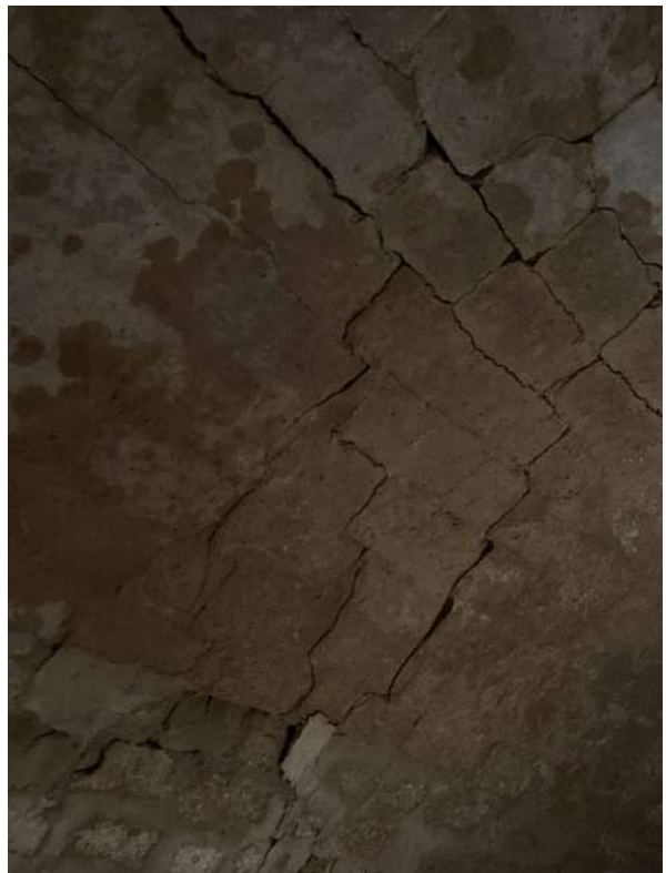
Volta soterrani torre. Esquerdes i moviments estructurals importants
