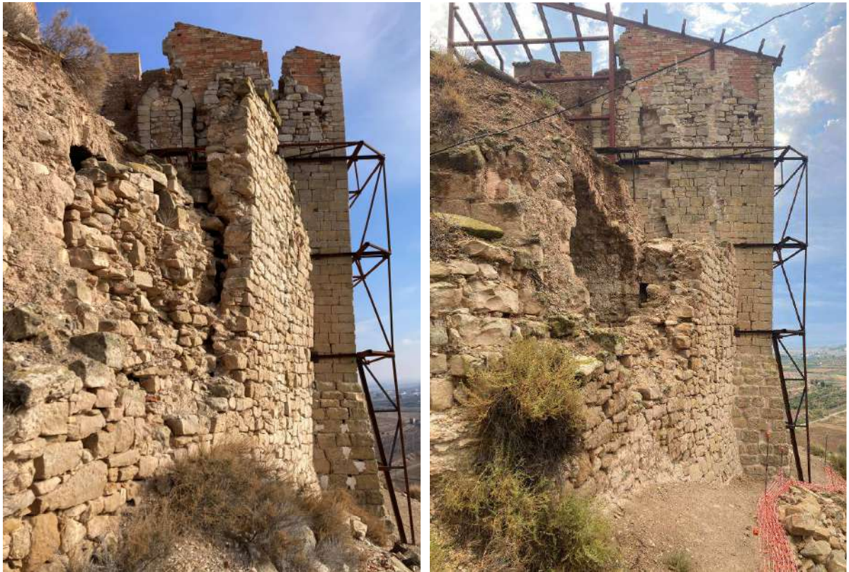
Comparativa abans i després de desmuntar el tram de mur amb risc de despeniment
