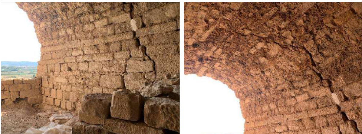
Vistes esquerda estructural de la volta
