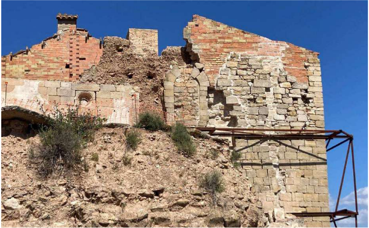
Reomplert i segellat d'esquerdes i separacions en la façana oest
