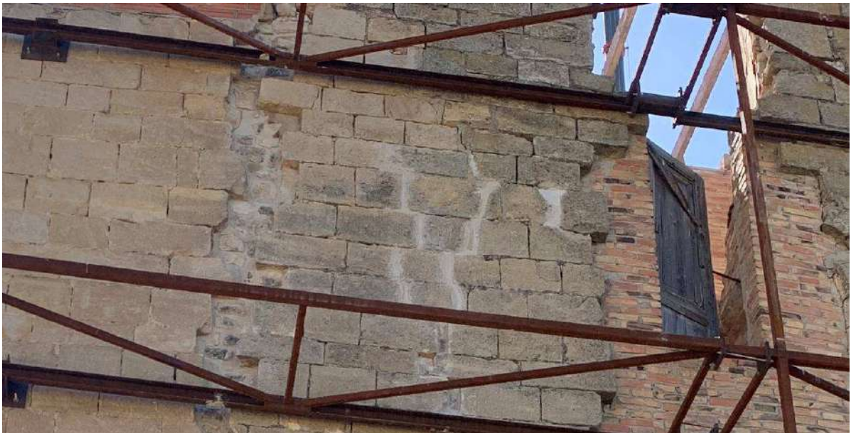
Detall del segellat de consolidació inicial
