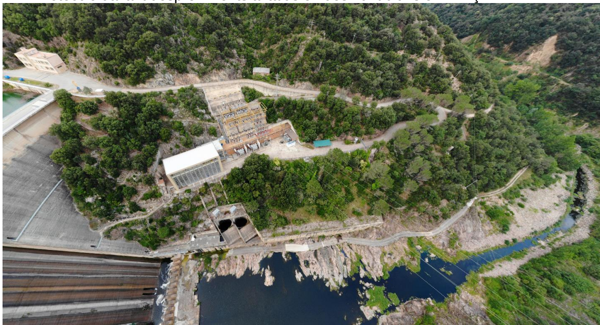
Imatge 8: Vista de l'entorn de l'actuació de millora d'accessos a l'embassament de Sau
