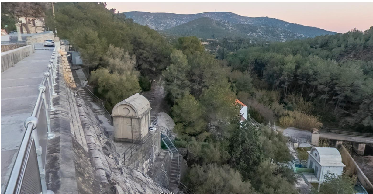
Imatge 9: Vista de l'entorn de l'actuació de millora d'accessos a l'embassament de Foix
