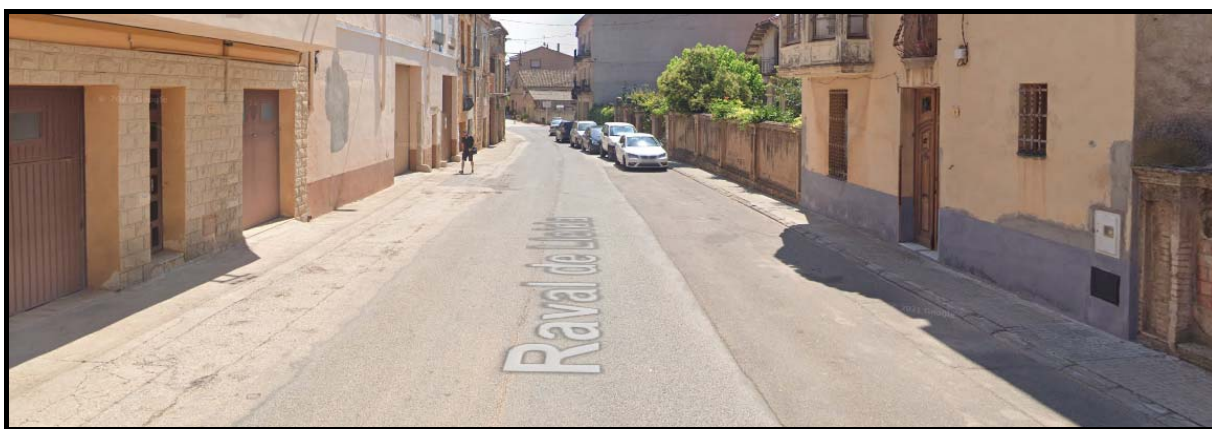
Començament de l'estrenyiment de la calada, amb vorera a la dreta i paviment diferenciat (formigó) de la calçada però al mateix nivell a l'esquerra.
