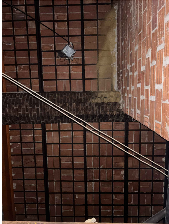
09 CUINES NIVELL 1- SOSTRE ORIGINAL, ESTRUCTURA DE SUPORT DE PAVES
