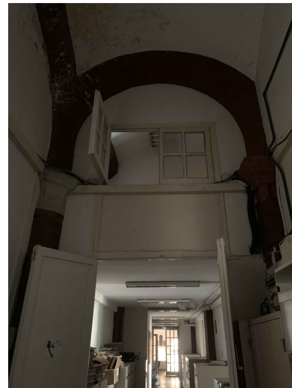
08 CUINES NIVELL 1- VOLTES ORIGINALS TAPIADES
