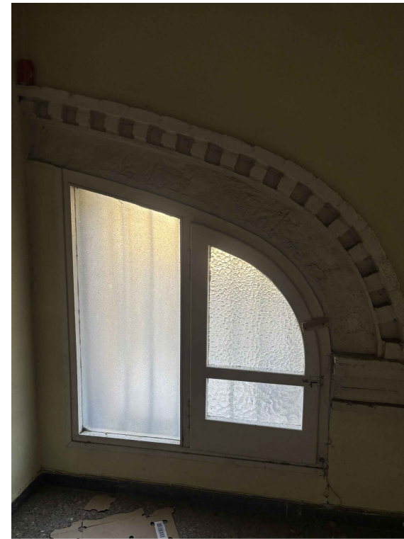
06 CUINES NIVELL 0 -INTERIOR ALTELL I VOLTA ORIGINAL
