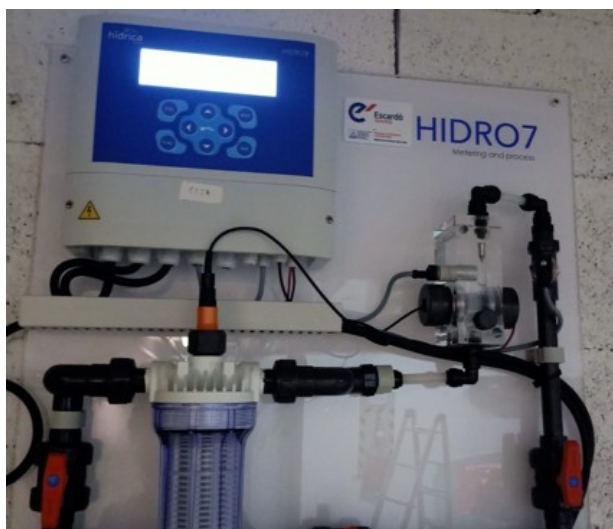
Sistema de cloració existent piscina estiu.
