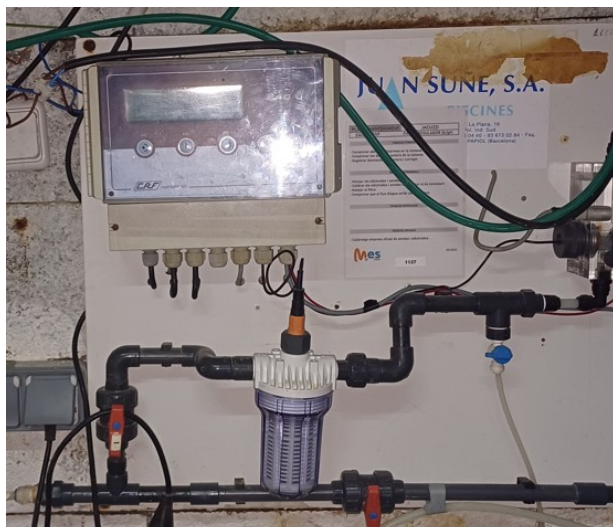
Sistema de cloració existent jacuzzi.
