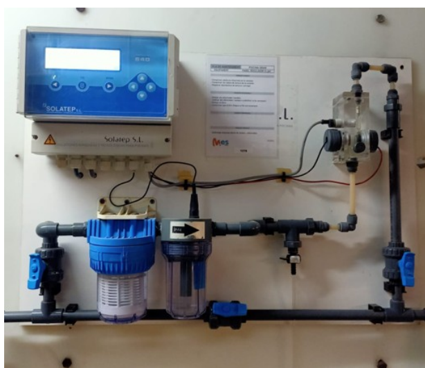
Sistema de cloració existent piscina gran.
