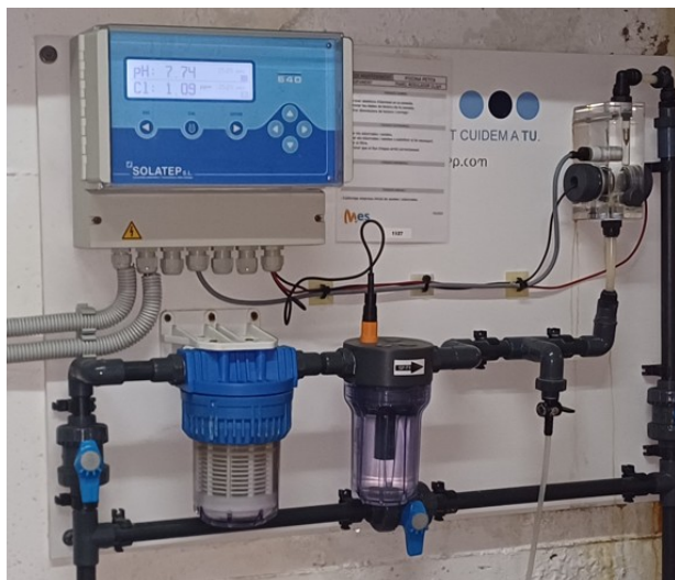
Sistema de cloració existent piscina petita.
