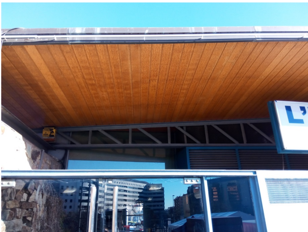
Façana lateral a remodelar
