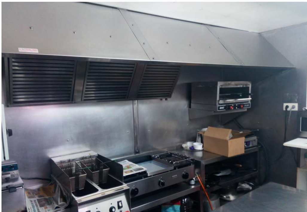
Campana existent de la cuina
