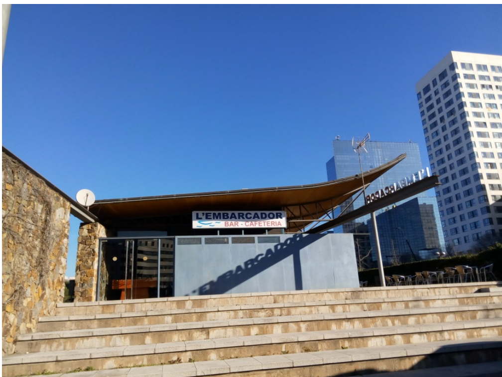
Façana lateral a remodelar
