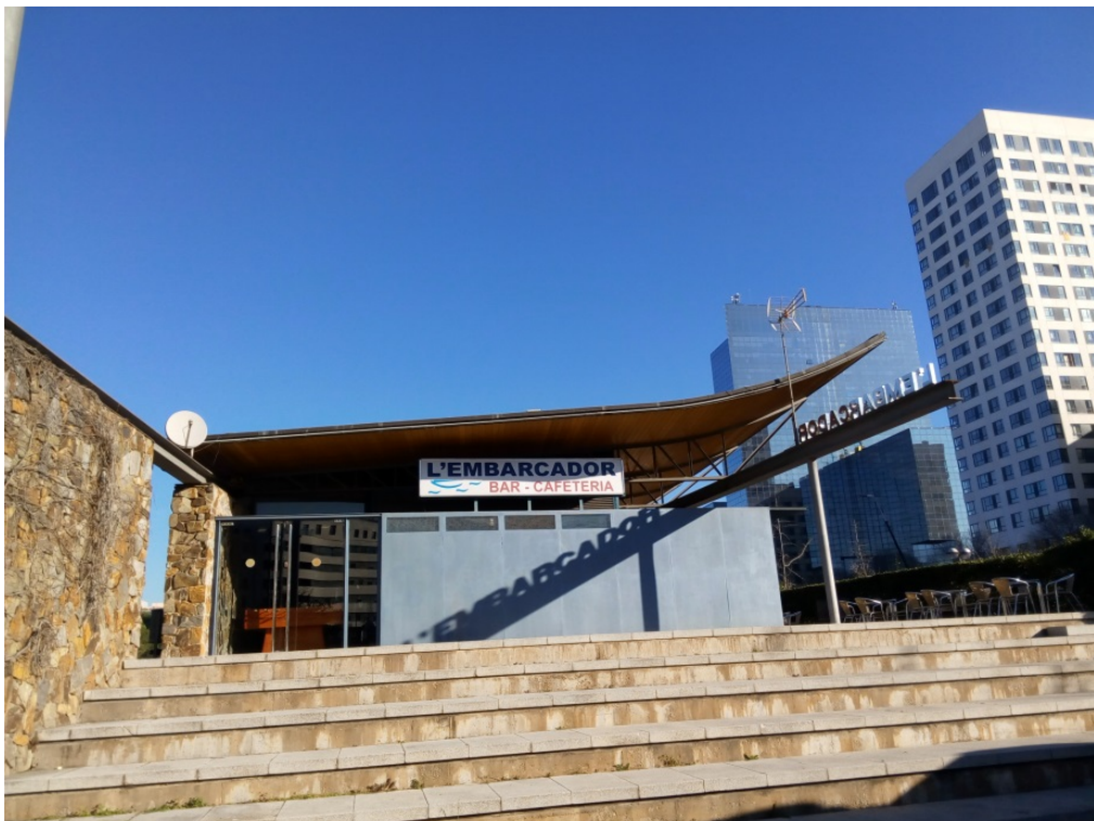
Façana lateral a remodelar
