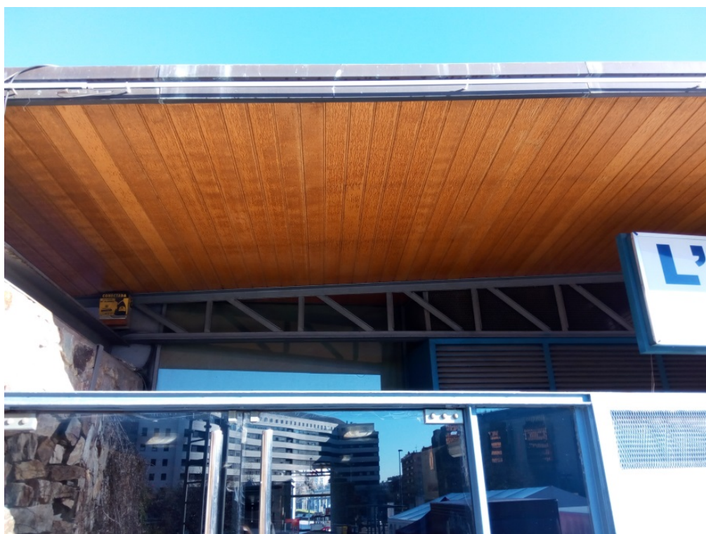
Façana lateral a remodelar
